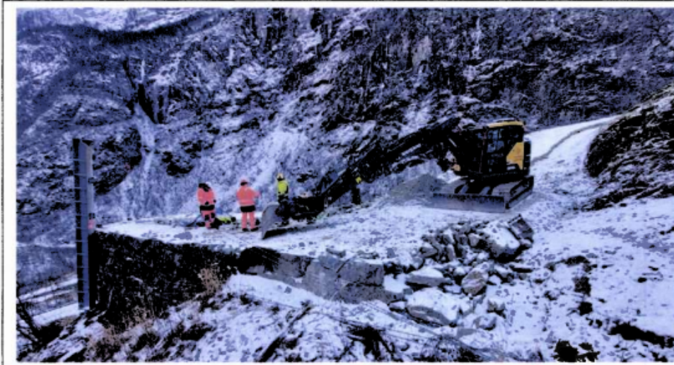
Bilde 1. Yttersvingen til 1840 muren treffer ca. ved stolpen. I alt.1 vil vannet ledes ut i en forlengelse av grøfta til høyre for steinrøysa. I alt.2 vil man måtte lage en åpning i den rette muren et sted i området ved stolpen.
