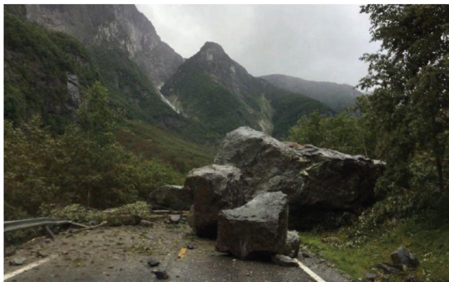
Figur 7 - Skredhendelse i 2016 hvor blokker på henholdsvis 100 m<sup>3</sup> og 30 m<sup>3</sup>, i tillegg til flere mindre blokker på 1-10 m<sup>3</sup> traff vegbanen. Foto: E. Eidsvåg, Sweco Norge AS.
