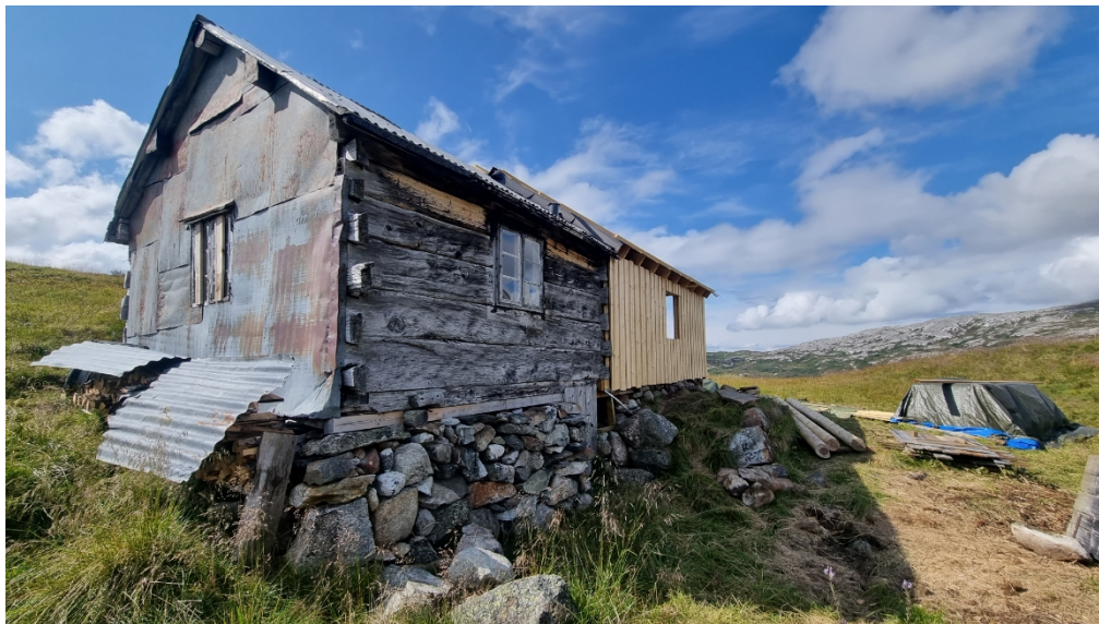
Figur 2 Bilde av stølshuset etter tiltak er sett i gang. Bildet viser åpning for vindauge i nordveggen, og heva takhøgde. Foto Kristoffer Ullern Hansen
