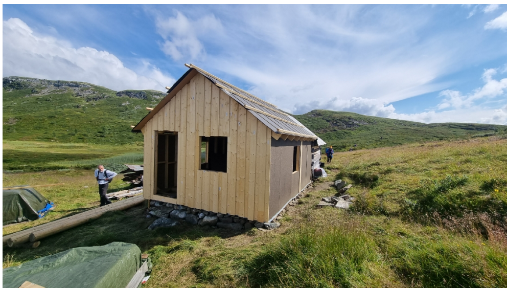
Figur 3 Bildet viser vestveggen med ny åpning for dør og endring av åpning for vindauga, og ny åpning for vindauge i sørveggen. Foto Kristoffer Ullern Hansen
