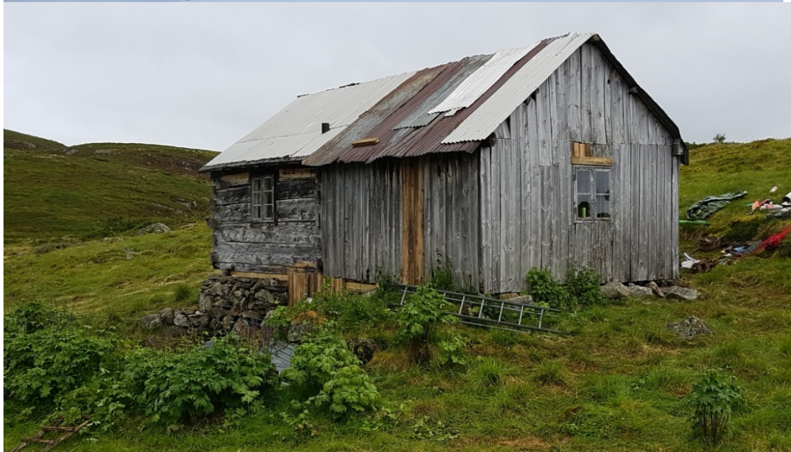
Figur 1. To bilde som viser stålshuset før istandsetting.
