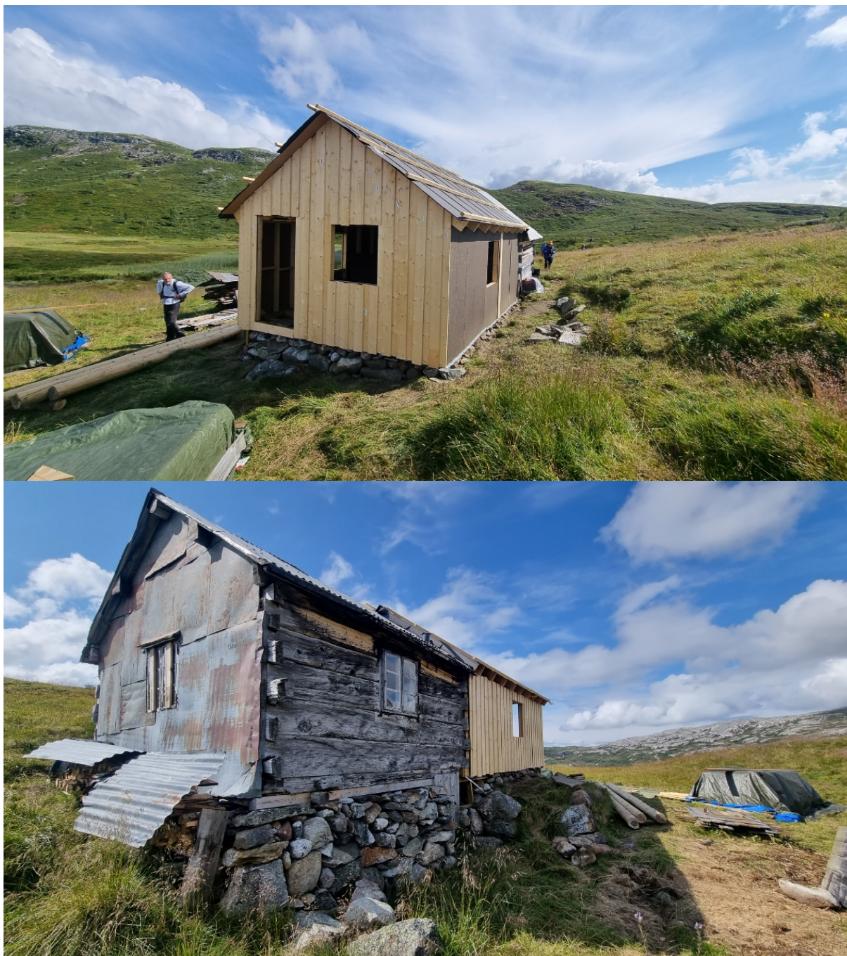
Figur 2. To bilete som viser stølshuset etter at tiltak er sett i gong.
