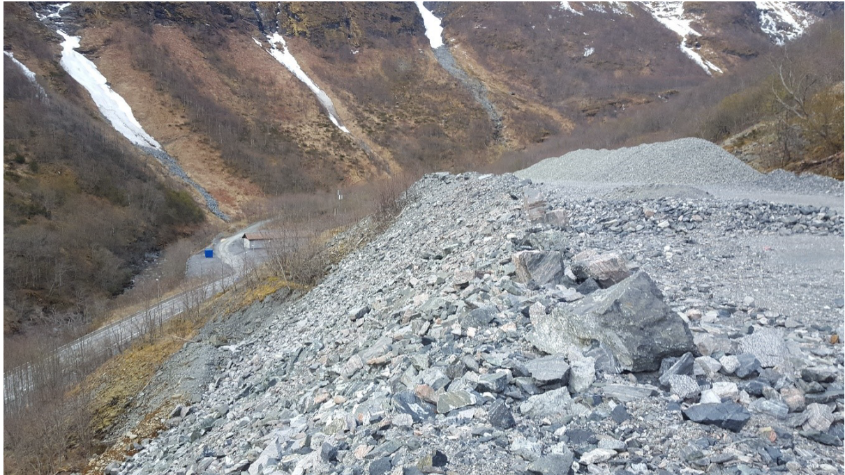
Deponerte massar på fyllinga ved Gudvangatunnelen. Kopi av bilde i brev frå Aurland kommune
