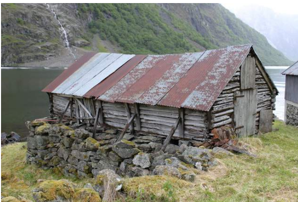
Naust på gbnr. 59/1 Ramsøy sør. Bygt 1908. Sterkt angripe av husbukk. Restaurering er vanskeleg p.gr.a. omfattande utskifting av treverk. Bør takast vare på slik det står.
