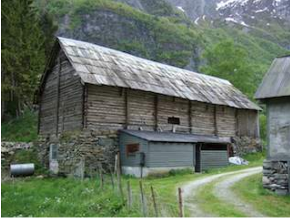
Driftsbygningen på gbnr. 65/1. 1800-1850. Taket vart restaurert i 2011.
