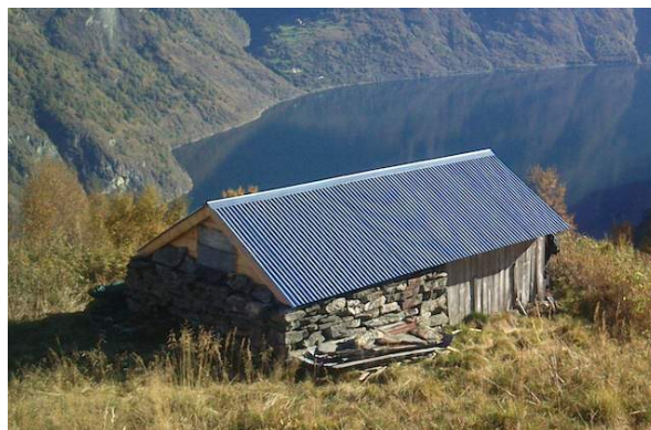
Selet til gbnr. 51/19. Særprega bygning med innsel i mur og skot i bindingsverk. Istandsett 2013.
