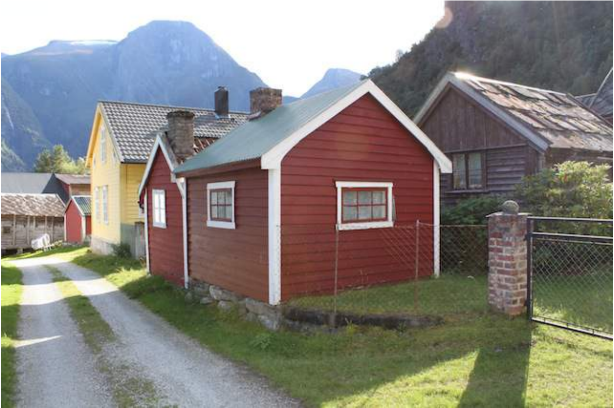
Bnr. 1, 2, 3, 4 og 5 utgjør klyngetunet i Dyrdal. 15 Sefrak-registrerte bygninger
