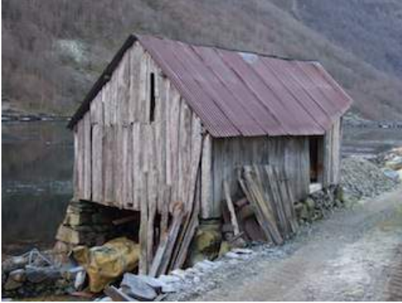
Gbnr. 65/2j Kløvanaustet. Kring 1900. Tilhører ein komplett husmannsplass med bustadhus, løy, eldhus og naust. I reguleringsplanen er det gjeve høve til flytting av naustet nærmare fjorden.
