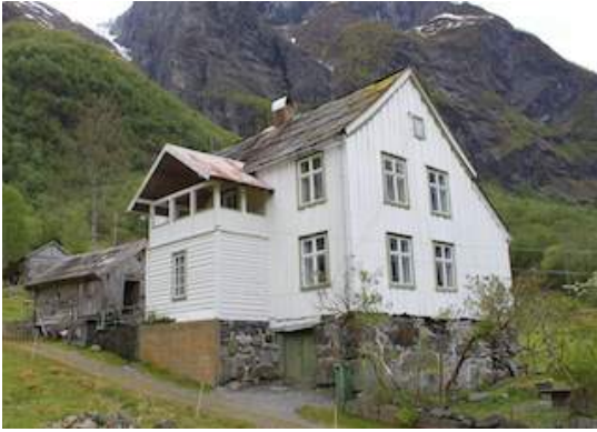
Våningshuset på bnr. 58/1. Bygt 1851. Bygningen er eit høgreist og særprega bygg særst synleg frå fjorden. Stil og byggjemåte har inspirasjon frå Austlandet.
