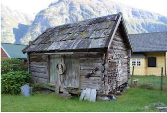
Stabbur på gbnr. 67/3. Før 1820. Einaste huset som stod att etter brannen i 1820.
