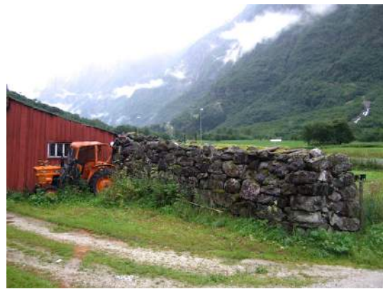
Vernemur mot fonnvind. Ein av svært få vernemurar mot fonnvind i Sogn og Fjordane. Eit sauefjøs er bygt inntil muren slik at den dannar eine vegen i bygningen. Det er gjeve tilskot til restaurering av vernemuren frå ordninga med tilskot til kulturminne på verdsarvlista.
