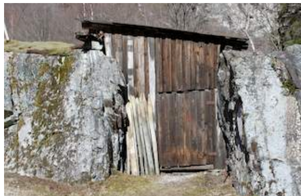
Reiskapshus på gbnr. 61/2. Spesiell bygning innbygt i ei fjellkløft, der fjellet utgjer to av veggane.
