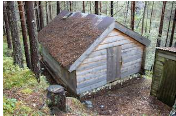
Stallen på Brendeli. Opprinneleg bygt som hytte på Hytteflaten i 1916, med stall i kjellaren. Flytta til Galden i 1926 og til Brendeli i 1932. Restaurert.
