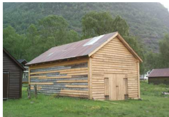
Naustet vart restaurert i 2013 med tilskot til kulturminne på verdsarvlista, Norsk kulturminnefond og Uni-stiftelsen. Omtalt i årsmeddinga for 2013 til Norsk kulturminnefond. Foto: Gry Mørk
