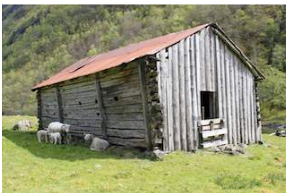
Sommarfjøs til gbnr. 58/2. 1800-talet. Det bør foretakast ei restaureringsfagleg tilstandsanalyse av bygningen for å vurdere om restaurering vil vere føremålstenleg.
