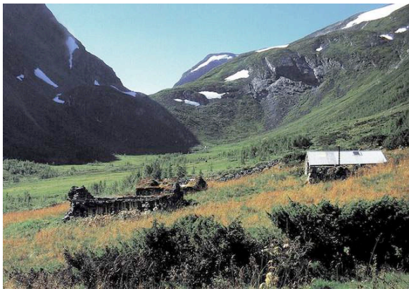
Murselet til gbnr. 30/3 er pålagt bølgeblikktak.
