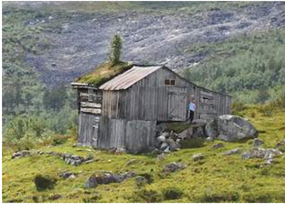
Karakteristisk sel med lafta innsel og skot i bindingsverk.
