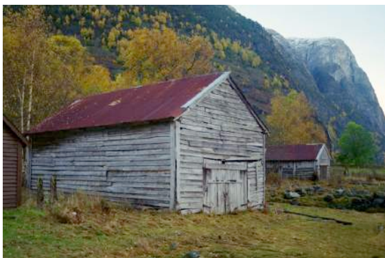
Gbnr. 67/12 Jensanaustet. Tilhørde tidlegare bnr. 67/2. Foto før restaurering.
