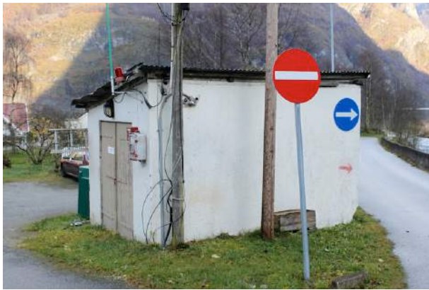
Gbnr. 51/95 Brannstasjon Særmerkt bygning i mur med bølgeblikkta. Avspeglar brannberedskapen i tida då Undredal var ei veglaus grend.
