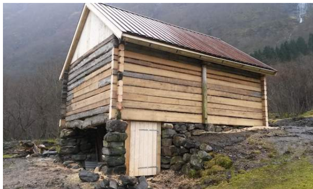
Lóa/tobakkshuset er no restaurert (2013).
