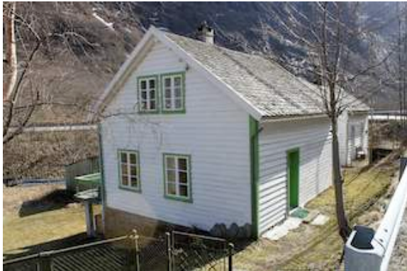
Gbnr. 64/2 Lassestova (bygt før 1900). Opphavelg lita stove av rundtømmer.
