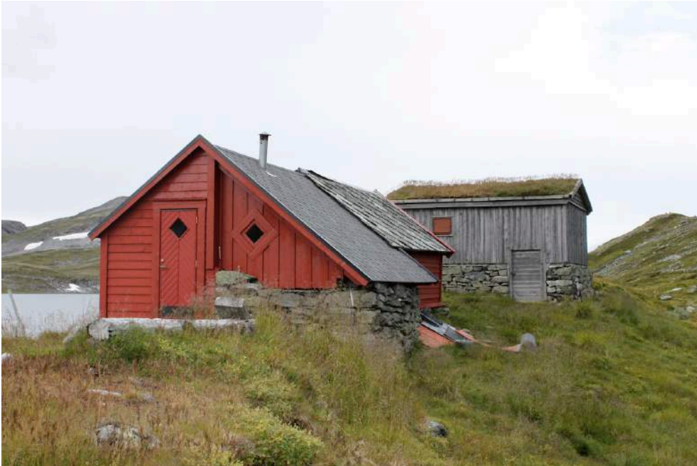
Gnr. 38 Vassete – 2 Sefrak-registrert bygningar. Selet til bnr. 38/1. Heimdal-selet. Ombygt 2002. Selet til bnr. 38/2. Framigard-selet. Nytt sel bygt 1982 på murane etter murselet.
