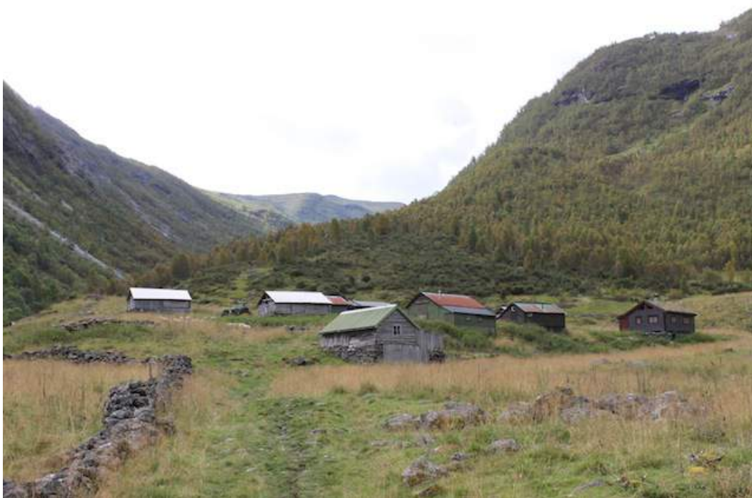
Gnr. 58, 67 og 69 Hjølmo. 9 Sefrak-registrerte bygningar.
