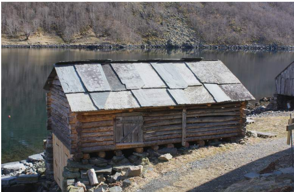
Nilsa Marta-naustet på Borgastrondi på Bakka er del av det autentiske husmannstunet Kløvåtunet. Eigar er båtvert for Kystled Nærøyfjord, og naustet vart restaurert til tradisjonell bruk som båtopplag og
