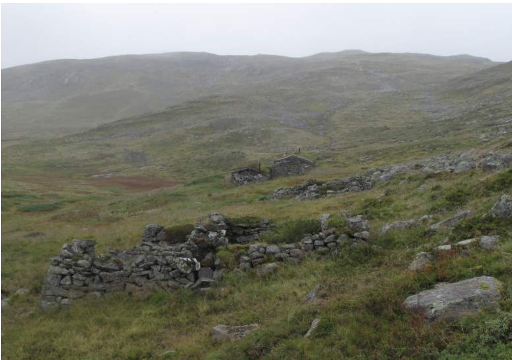
Gbnr. 48 Tyrva. 2 Sefrak-registrerte bygningar i naturstein. Tidlegare geitefjøs og mjølebu. Bygningane er istandsette og pålagde torvtak, til bruk som hytter. Foto: Kristoffer Ullern Hansen.
