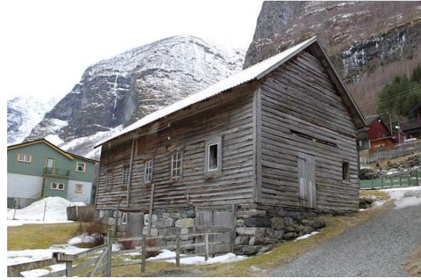
Gbnr. 51/32 Løa i Pettergarden, bygt 1898 (før utskiftinga ). Flytta ved utskiftinga.
