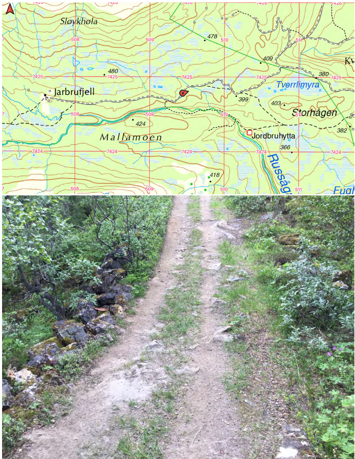
Figur 13. Punkt 9. Eksempel på gammel oppfylling/forstøtning av kjøresporet med stedege masser som glir godt inn i terrenget uten noen negativ påvirkning på naturverdier. Steinen er brutt ut fra berget i øvre billedkant (til høyre). UTM 33W 509444 7424782 Link til punktet i Norgeskart.
