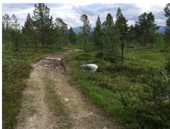
Figur 6. Punkt 2. Kjøresporet splitter to myrarealer som opprinnelig har en sammenheng i et søkk der den øvre myra (sørsiden av vegen) drenerer ut i den nedre myra. Den nedre myra er ei rikmyr. Den øvre er intermediaær. Kjøresporet endrer på den naturlige dreneringen, noe som er uheldig. Dette kan rettes opp ved å legge drenerør på det laveste punktet på kjøresporet og grove drenerende (stedegne) masser oppå der. Ei grøft i den nedre myra (nordsiden av vegen) bør fylles mest mulig igjen, men uten bruk av anleggsmaskin i myra, slik at man unngår uttørring. Koordinater: UTM 33W 510048 7424901 Link til punktet i Norgeskart.
