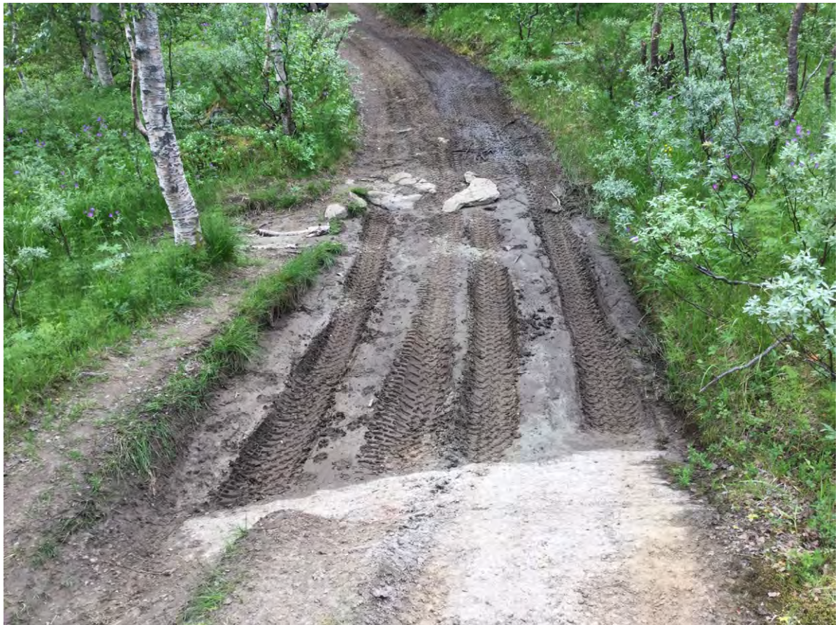
Figur 12. Punkt 8. Gjørmete parti gjennom litt kalkrik myrkantmark. Her stopper ikke kjøresporet naturlig drenering, og noe negativ virkning er ikke mulig å se fra om lag en meter ut til siden. Drenering og/eller noe grove drenerende masser (stedegen pukkstein eller lignende) vil likevel være en fordel for å unngå ytterligere utvasking. UTM 33W 509466 7424821 Link til punktet i Norgeskart.
