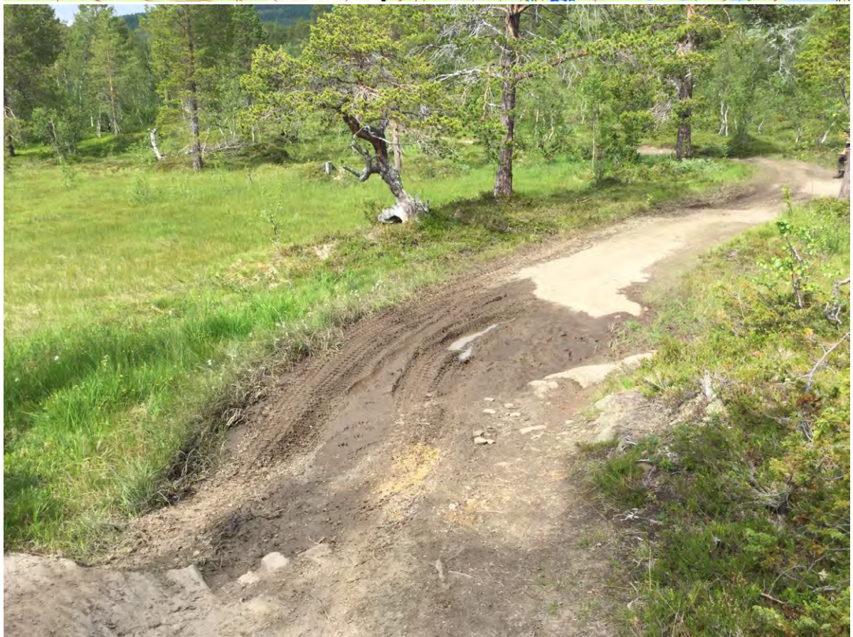
Figur 8. Punkt 4. Gjørmete parti gjennom myr med intermediær karakter. Myra er ikke så rik som i punkt 1, men det kan med fordel også her gjennomføres drenering i kjøresporet og påfyll av grove masser (eventuelt kun det siste), slik at man unngår en utvidelse av trasébredden og at opprotet mineralmateriale og humus fra kjøresporet skylles ut på myra i regnværstperioder. UTM 33W 509970 7424931 Link til punktet i Norgeskart.
