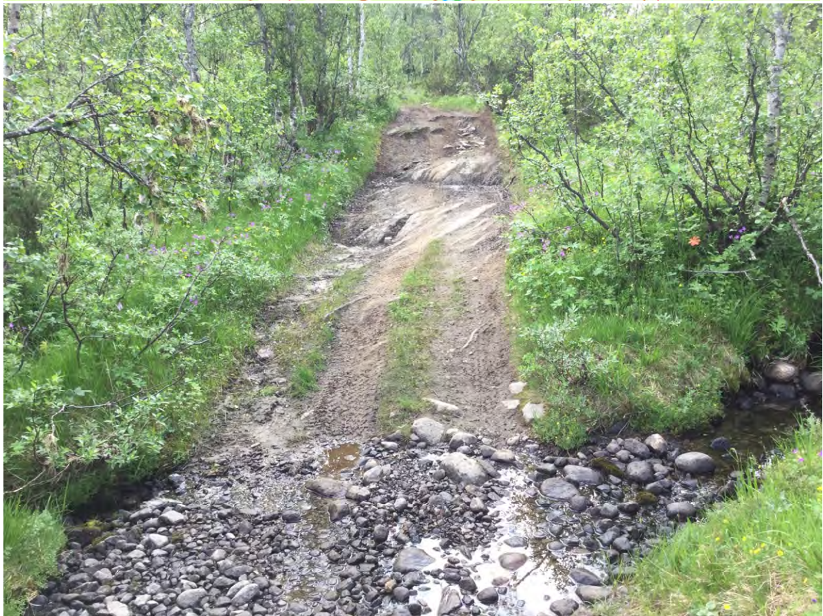
Figur 16. Punkt 12. Punkt vest for Tverrlimyra der det ikke er nevneverdige naturverdier, men der vegen med fordel kan planeres noe med grove, stedege masser, eventuelt at det legges plank eller lignende i hjulsporene, for at den skal framstå bedre i landskapet. Over bekken bør det eventuelt legges drenering og/eller grove drenerende steinmasser. UTM 33W 510335 7424839 Link til punktet i Norgeskart.
