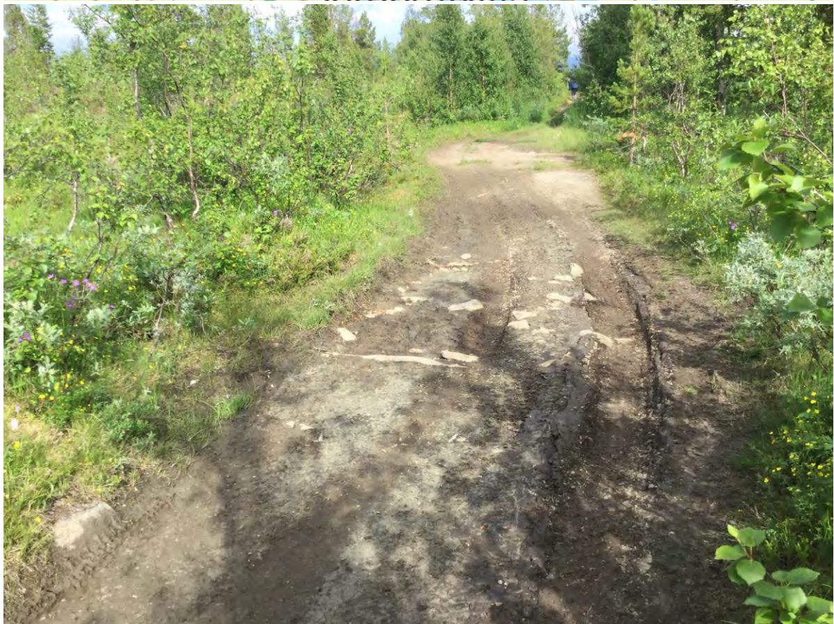
Figur 18. Punkt 14. Også dette er et punkt der kjøresporet har blitt bredere enn nødvendig fordi man har prøvd å unngå et gjørmehull. Her kan det fylles med stedegen kuppelstein/pukk for å reetablere kjøresporet i kun én kjørebane. Her er ingen nevneverdige naturverdier. Herfra og utenfor verneområdegrensa er kjøresporet mer forseggjort. UTM 33W 510620 7425019 Link til punktet i Norgeskart.
