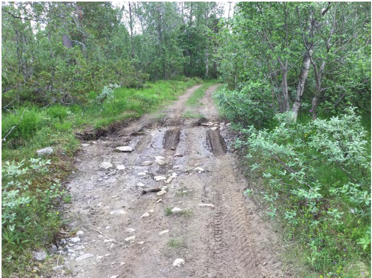
Figur 10. Punkt 6. Gjørmete parti gjennom svakt kalkrik myrkantmark. Her er det laget en enkelt dreneringsløsning fra før. Det er mulig å forbedre også denne for å unngå at kjøringen eroderer enda mer ned i lømassene. UTM 33W 509663 7424883 Link til punktet i Norgeskart.
