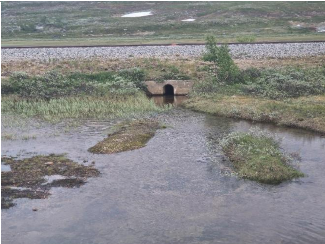
Figur 10: Innløp stikkrenne km 585,712 tatt fra E6
