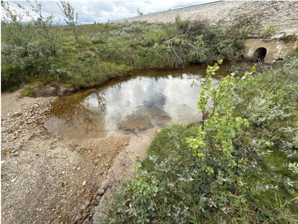
Figur 17: Kulp nedstrøms utløp som viser sandbanke, km 587,333
