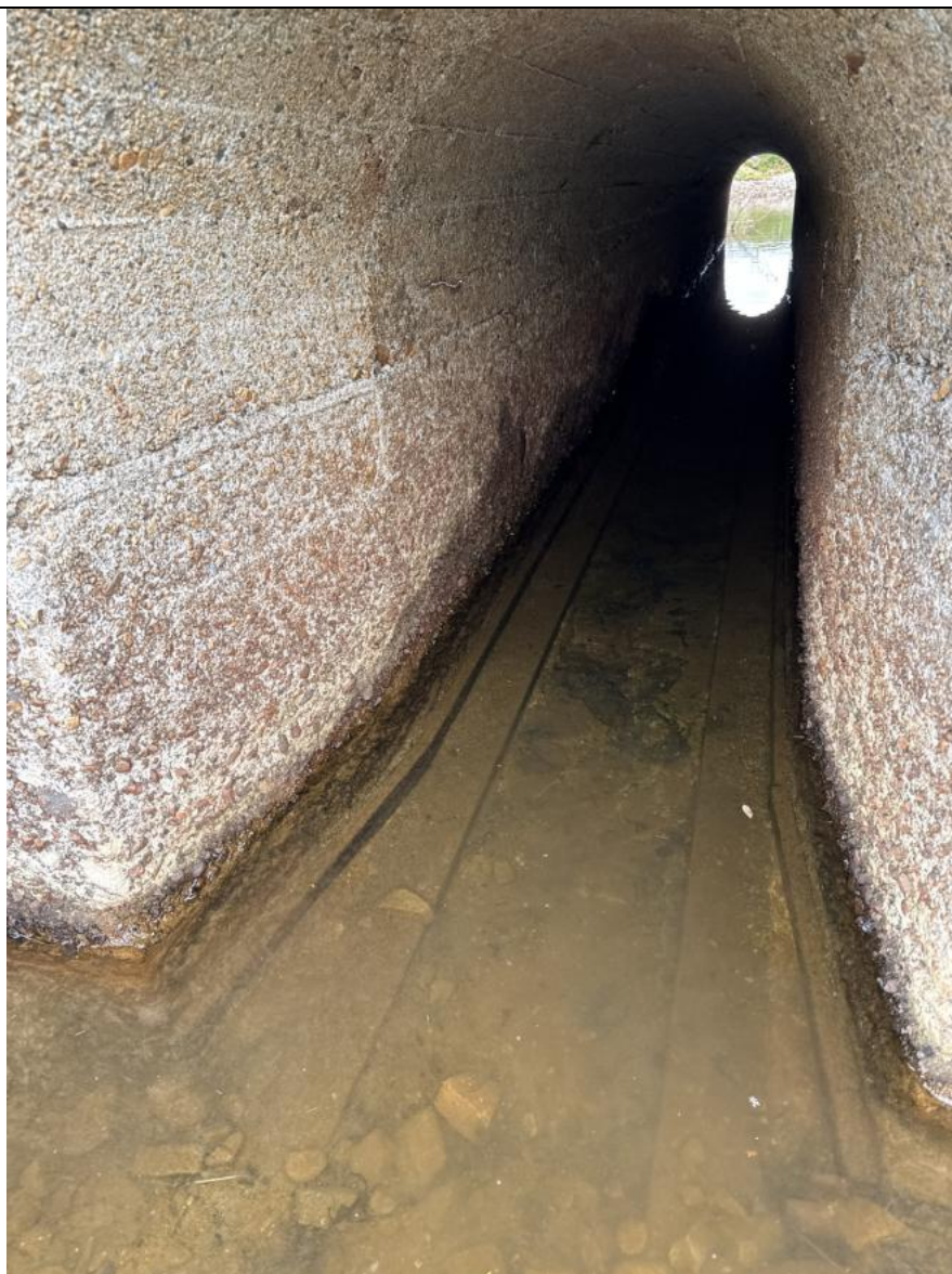
Figur 15: Inni stikkrenna sett fra innløp, km 587,333
