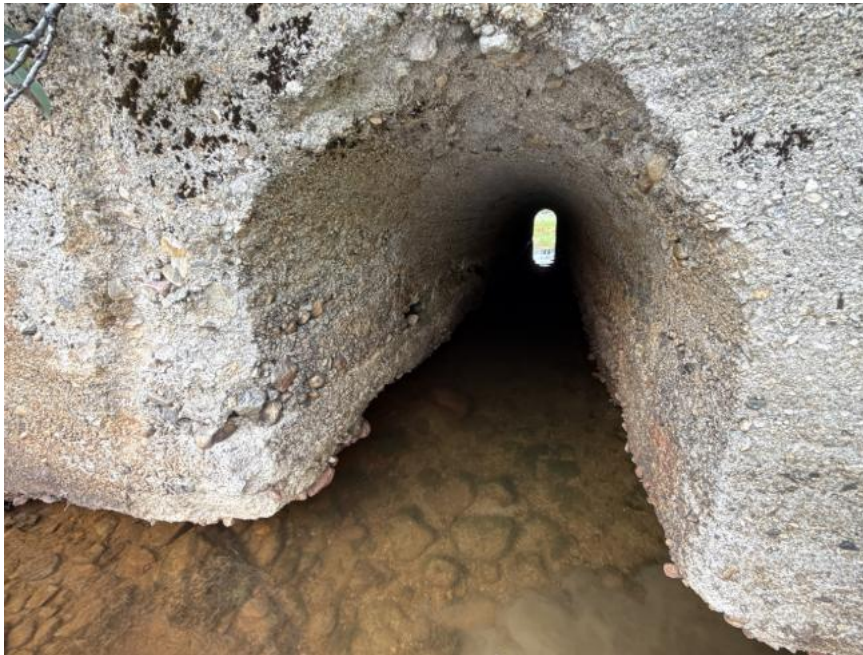
Figur 12: Utløp, inn i stikkrenna, km 585,712
