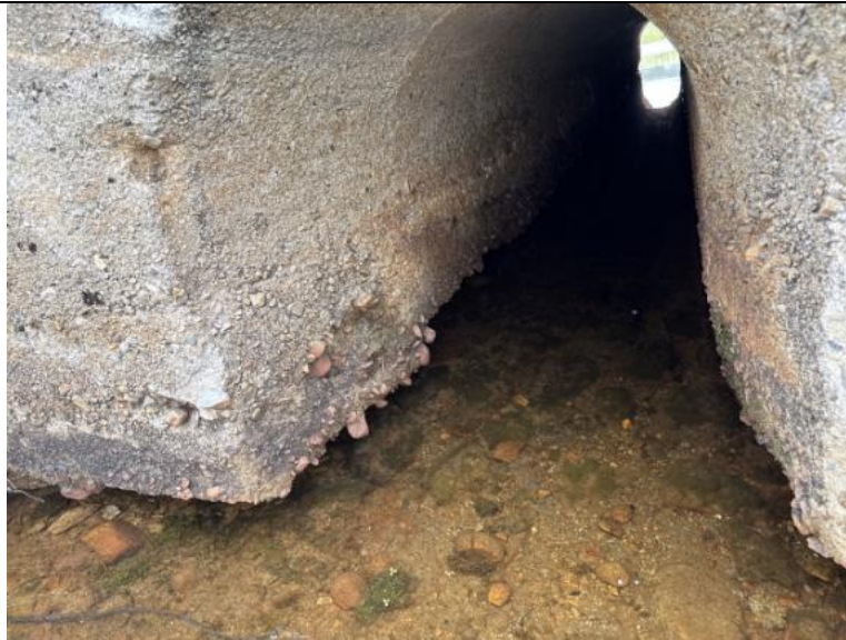
Figur 9: Innløp stikkrenne km 585,712
