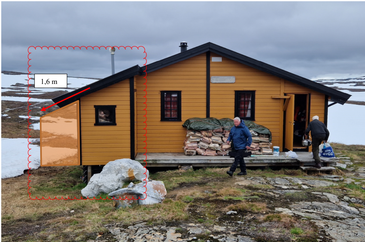
Figur 2: Nord-fasade: Dagens vedbod med omtrentlig utvidelse. I søknaden er det kun den røde streken som er tegnet inn. Resten (pila og skissert utvidelse) er lagt inn av sekretariatet. Her ser vi at eksisterende plattform går i kant med eksisterende vedbod. Plantegningene i figur 1 viser en plattform som stikker utenfor eksisterende vedbod, som skal gå i kant med omsøkt vedbod. Sekretariatet avdekket denne feilen, og behandler plattform som et eget tiltak.
