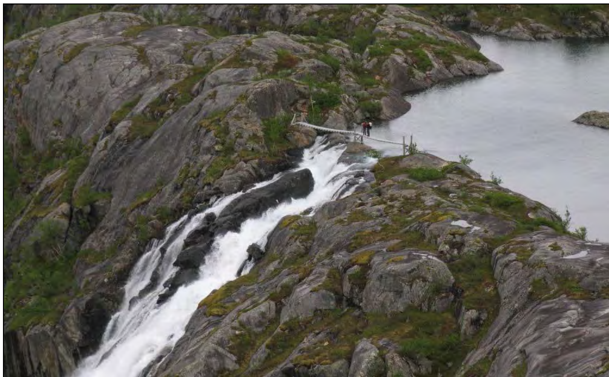
Hengebrua over Litlverivassfossen
