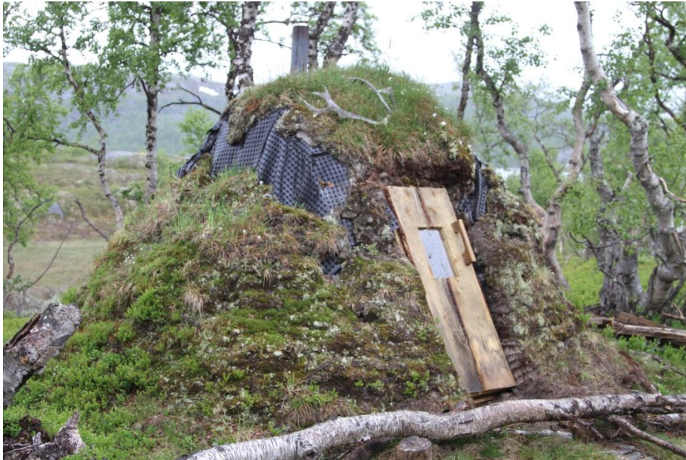
Det er satt i ny dør ved gammen ved Storoksvatnet. I 2015 må det legges på mer torv. Foto Kristian Sivertsen
