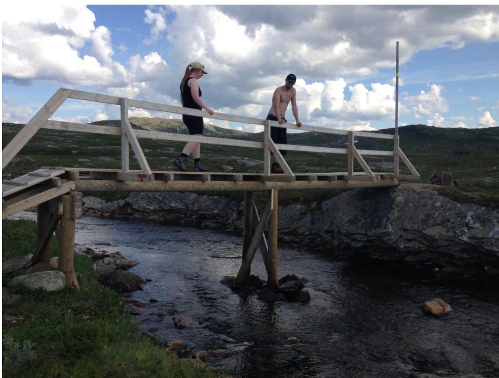
Fjelltjenesten har reparert bro ved Tverrbrennelva. Foto Stein Ove Johannesen
