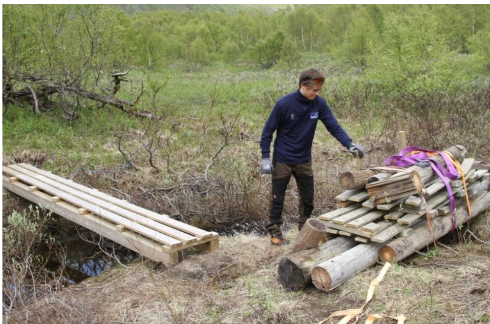
Gamle broer av kreosot holdige materialer er demontert og fløyet ut fra Stormdalen. Foto Kristian Sivertsen
