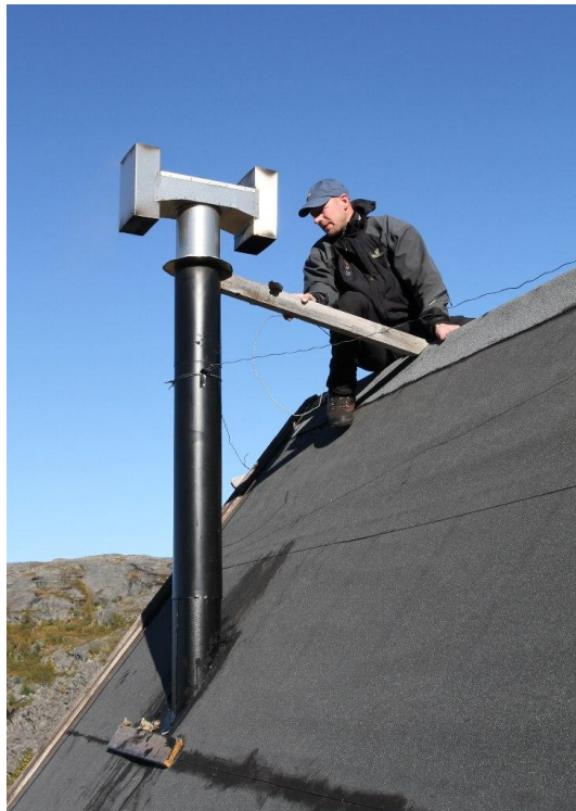
Figur 21 og 22. Oskar Pettersen i sving med å legge på takpapp på Ragohytta (bilde til venstre). Reparasjon av tett pipe (bilde til høyre).
