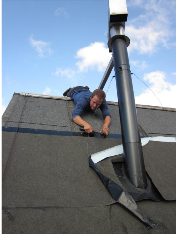
Figur 21 og 22. Oskar Pettersen i sving med å legge på takpapp på Ragohytta (bilde til venstre). Reparasjon av tett pipe (bilde til høyre).
