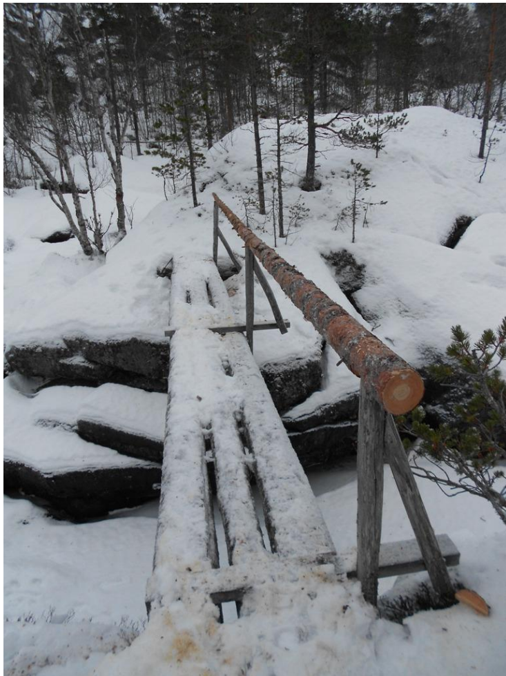
Figur 11. Nytt rekkverk er montert. Foto: Tore Veisetaune
