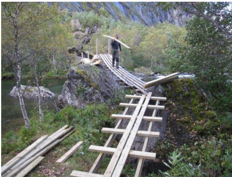
Ivan Johannessen (innleid hjelp) i arbeid med å sette opp den nye hengebrua ved Mellomforsen.
