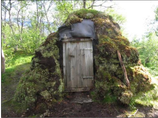
Bilder av Sørengamma før utbedring
