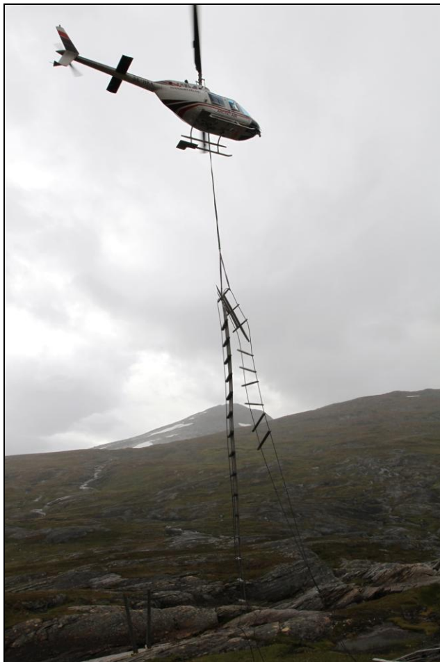
Hengebrua i Storengdalen flys ut september 2014. Foto: Jim Tovås Kristensen
