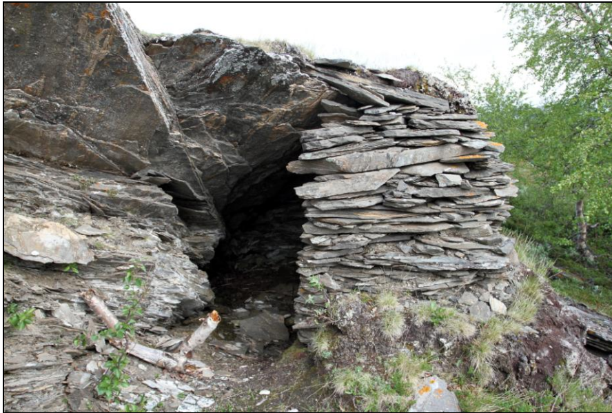
Kulturminne langs Rosnaelva i 2014. Døra til steinbua har blitt ødelagt og må erstattes. Foto: Jim Tovås Kristensen
