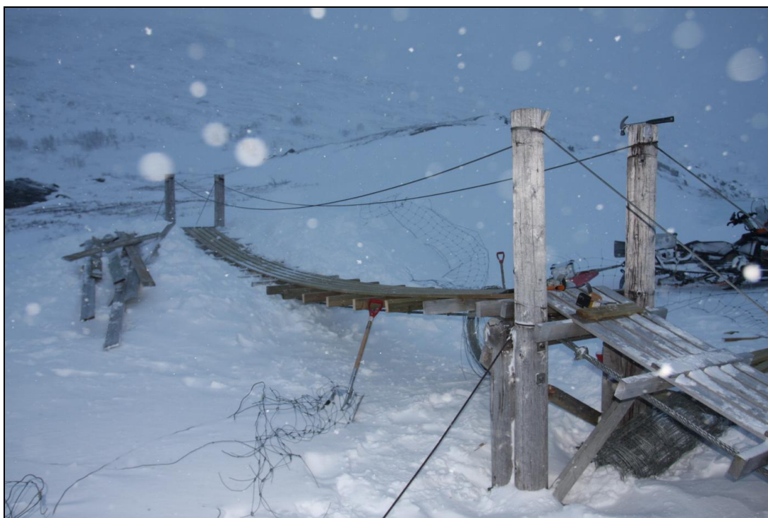
Hengebrua i Skaitikjeften under reparasjon januar 2013. Foto: Jim Tovås Kristensen
