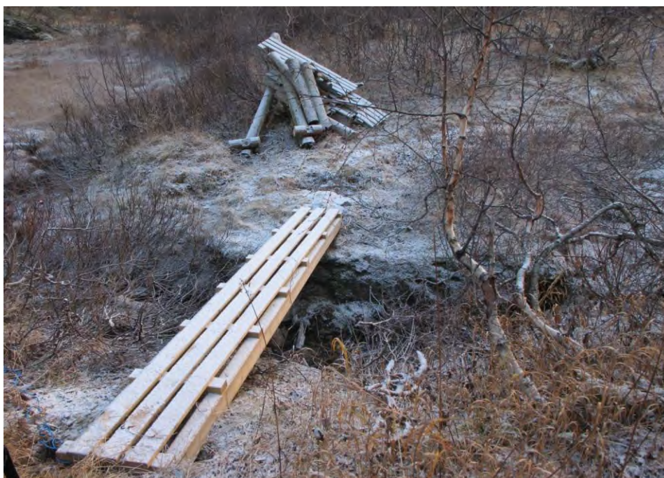
Gammel bru demontert for utkjøring, ny stokkbru på plass. Foto Kristian Sivertsen
