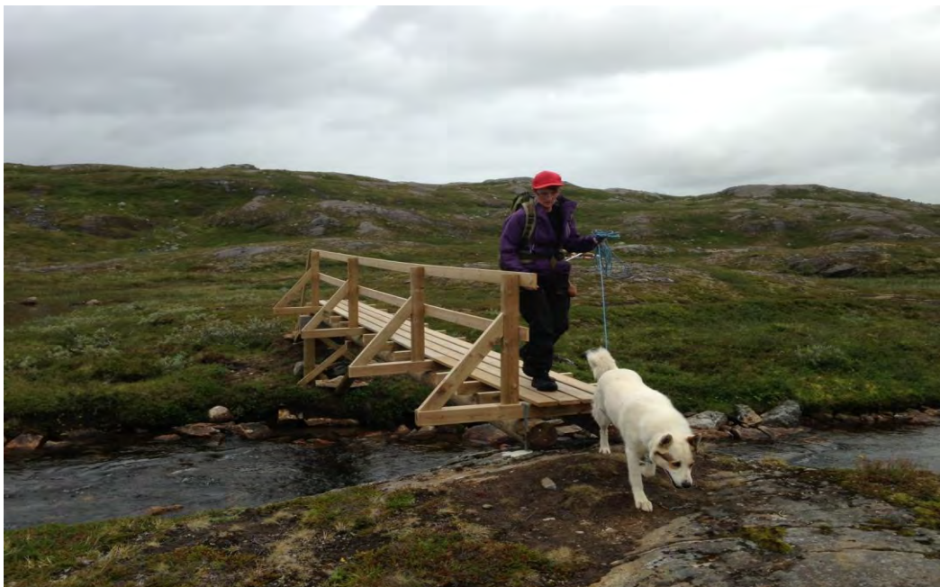
Statskog Fjelltjenesten har på oppdrag fra BOT bygget Stokkbru ved Tverrbrennstua. Foto Stein Ove Johannessen
