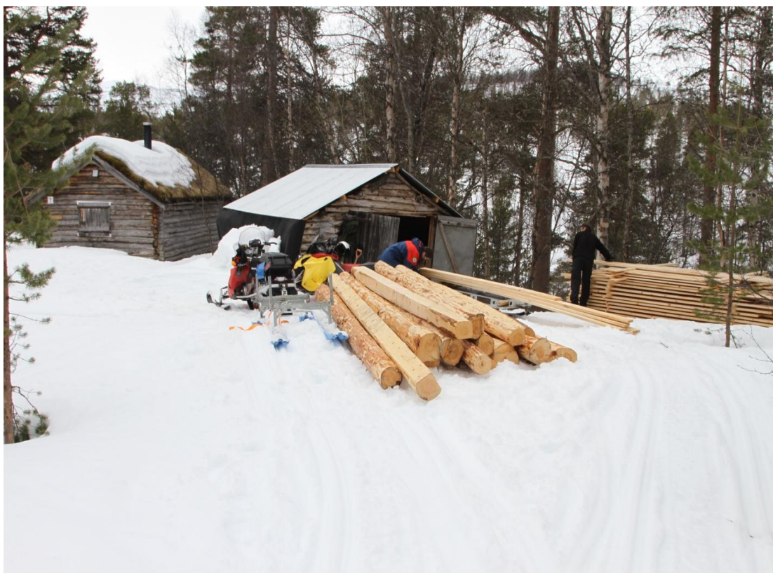
Transport av materialer til restaurering av stallen ved Jordbruhytta. Foto: Kristian Sivertsen
