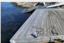
Utvidelse av den ene byggen, samt rampe for bil er blant det som ligger til grunn for forfølgnet. FOTO: POLITIET
