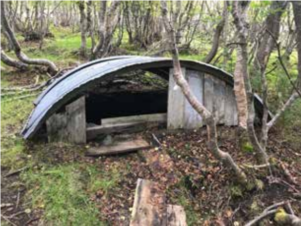
Over: Brønnhuset. Foto: NTRM
