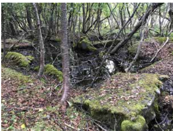
Over: Støpt dam til vannforsyning i utmarka over Storbukta. Foto:NTRM
