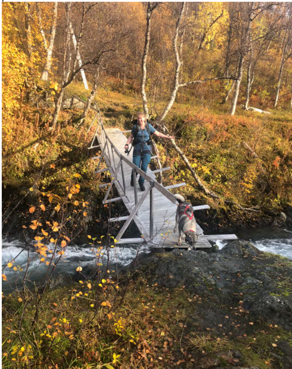
Brua i Fastdalen, høsten 2021
