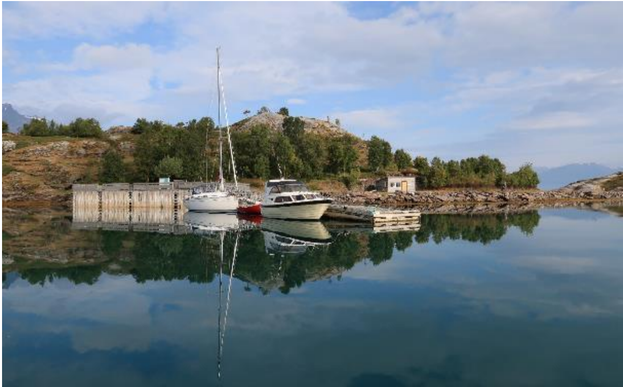
Kaianlegget 2019. (Foto: Tine Marie Hagelin)
