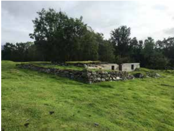
Over: Askeladden ID 236331-1 er tuftene etter to våningshus - ett eldre med grunnmur av steinhellere, og ett yngre med grunnmur i betong. Det siste skal være oppført etter krigen. Registrert i Sefrak med id. 0206-007. Foto: NTRM.
