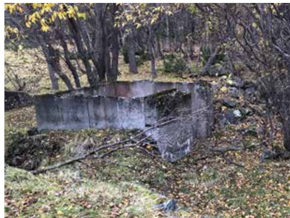
Over: Grunnmur med betongkasse, muligens fjøs (kartets nr. 4). Foto: NTRM.
