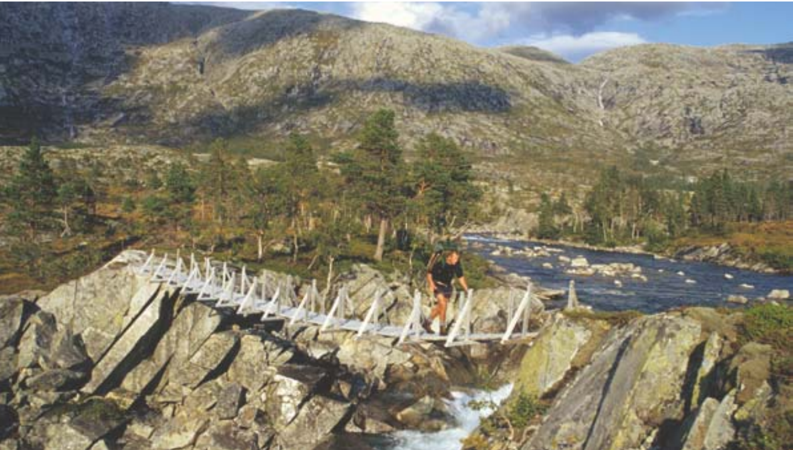
Hengebru over Gardsfossen i Lomsdalen. (Foto: Halvard R. Pedersen)
