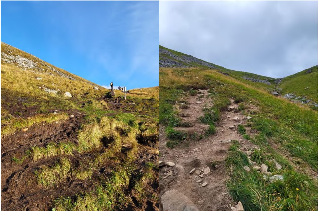
Figur 10. Til venstre: Eksempel på et fuktsig/ bløthøl på traseen som nå skal utbedres. Her skal stien legges i overkant av bløthølet på tørrere grunn. Til høyre: Eksempel på en bratt skråning med ustabil substrat. Her er det mye løsmasser som kommer fram etter hvert som vegetasjonsdekket slites bort. Dette eroderes videre av ferdsel og utvasking som følge av nedbør.
