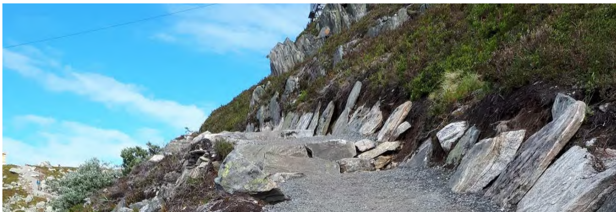
Figur 15. eksempel på skråstilte steinheller som sikring mot erosjon fra heng-siden. Foto: Utmarksressurser AS.
