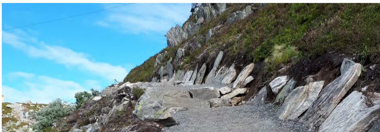
Figur 14. eksempel på skråstilte steinheller som sikring mot erosjon fra heng-siden. Foto: Utmarksressurser AS.
