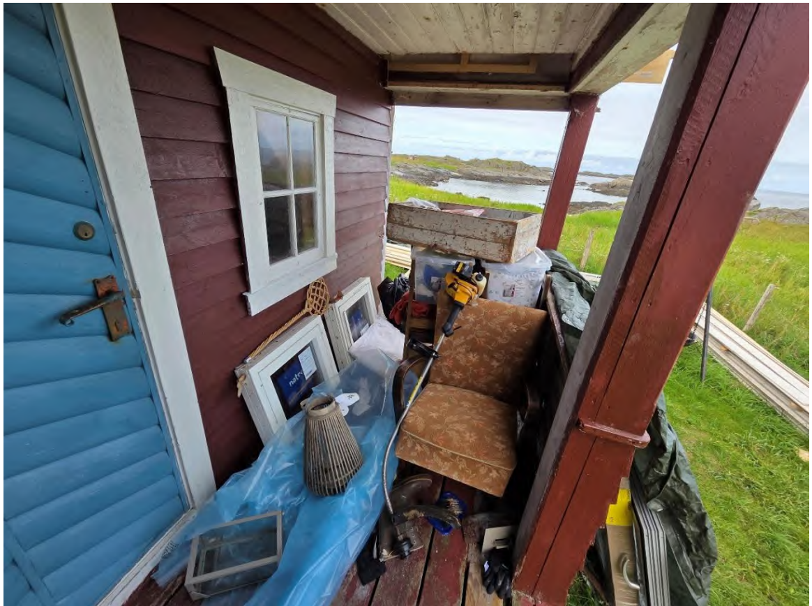
Bilde 17 Detalj av ytterdør og vindu i inngangsparti
