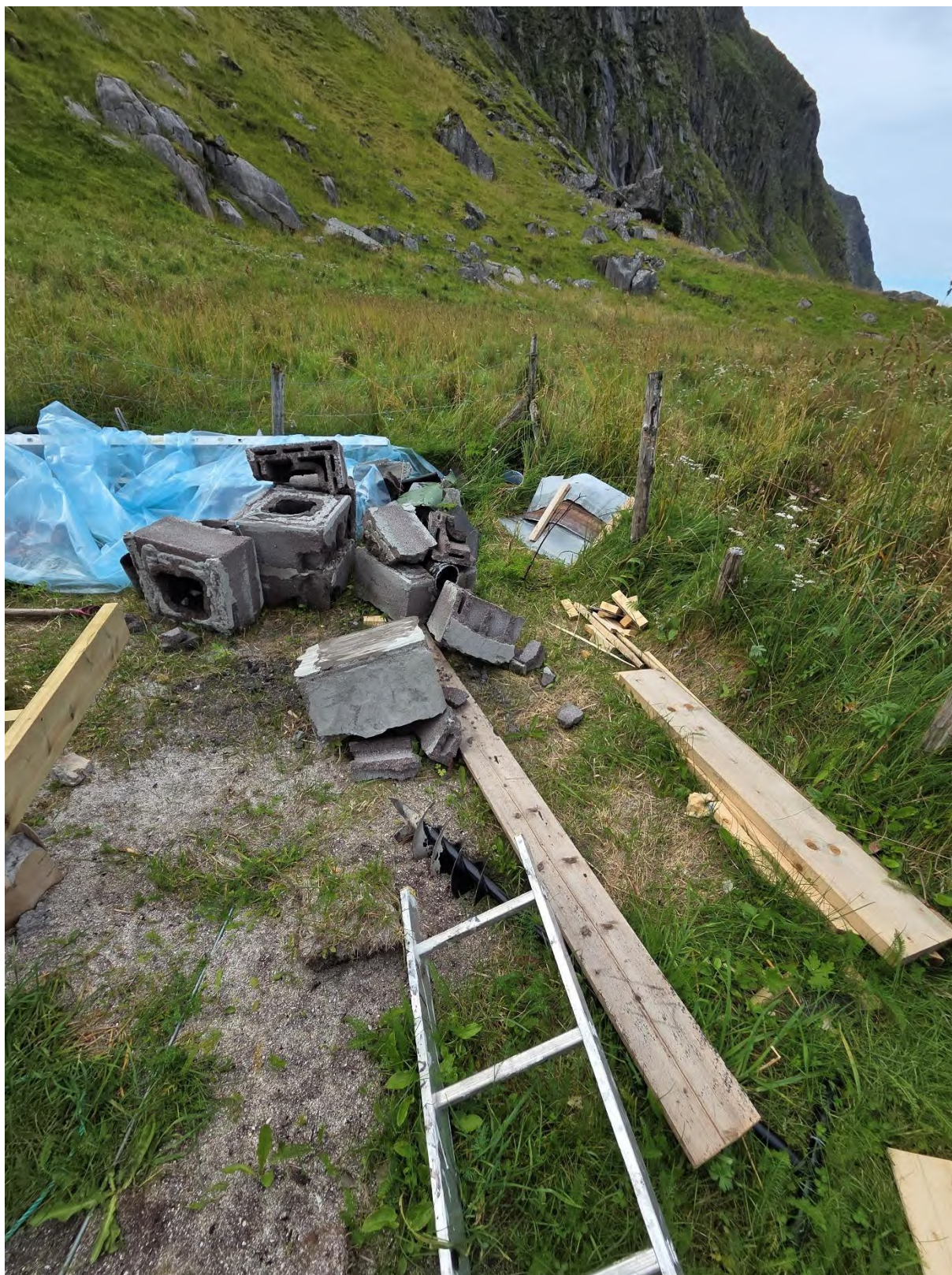
Bilde 30 Detalj av bygningsmaterieell lagret utenfor på sørsiden
