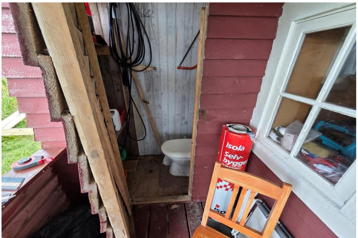
Bilde 18 Detalj av toalettrom i inngangsparti
