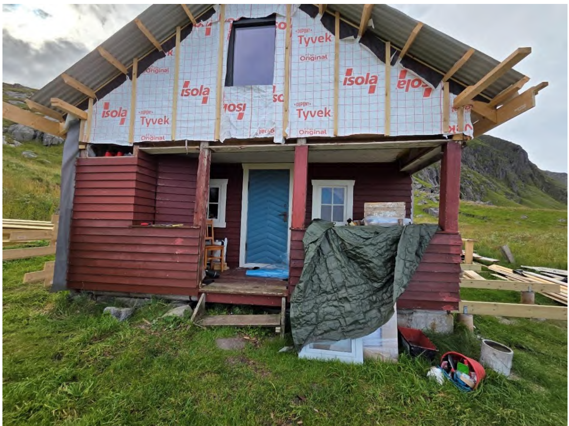
Bilde 16 Oversikt over inngangsparti på gavlvegg mot NØ
