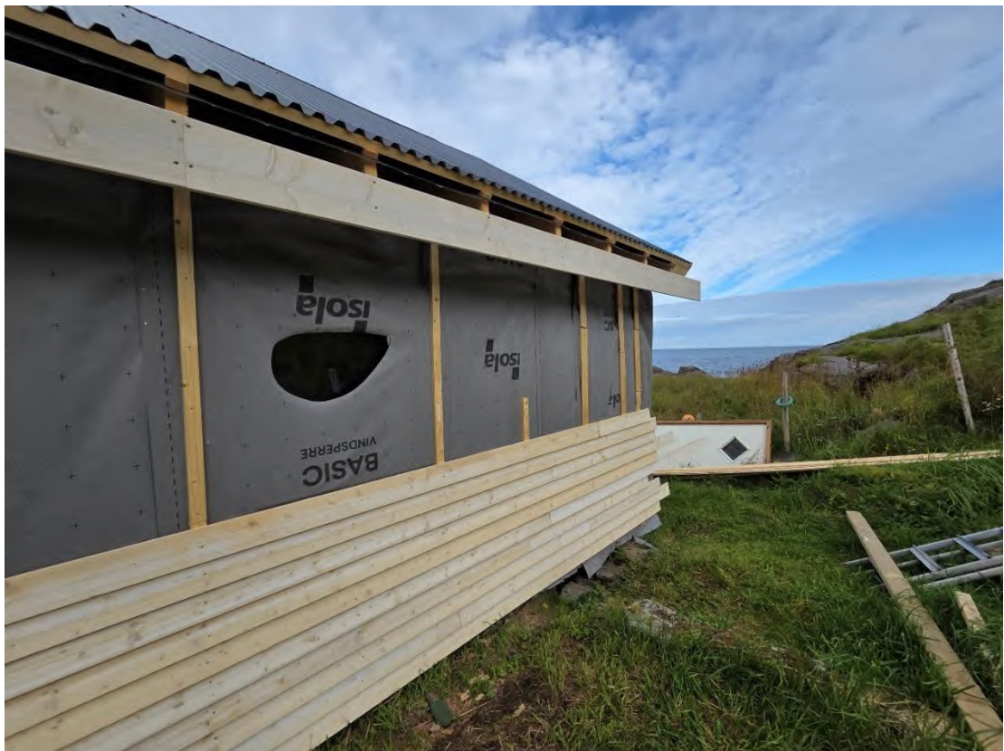
Bilde 12 Detalj av langvegg mot SØ
