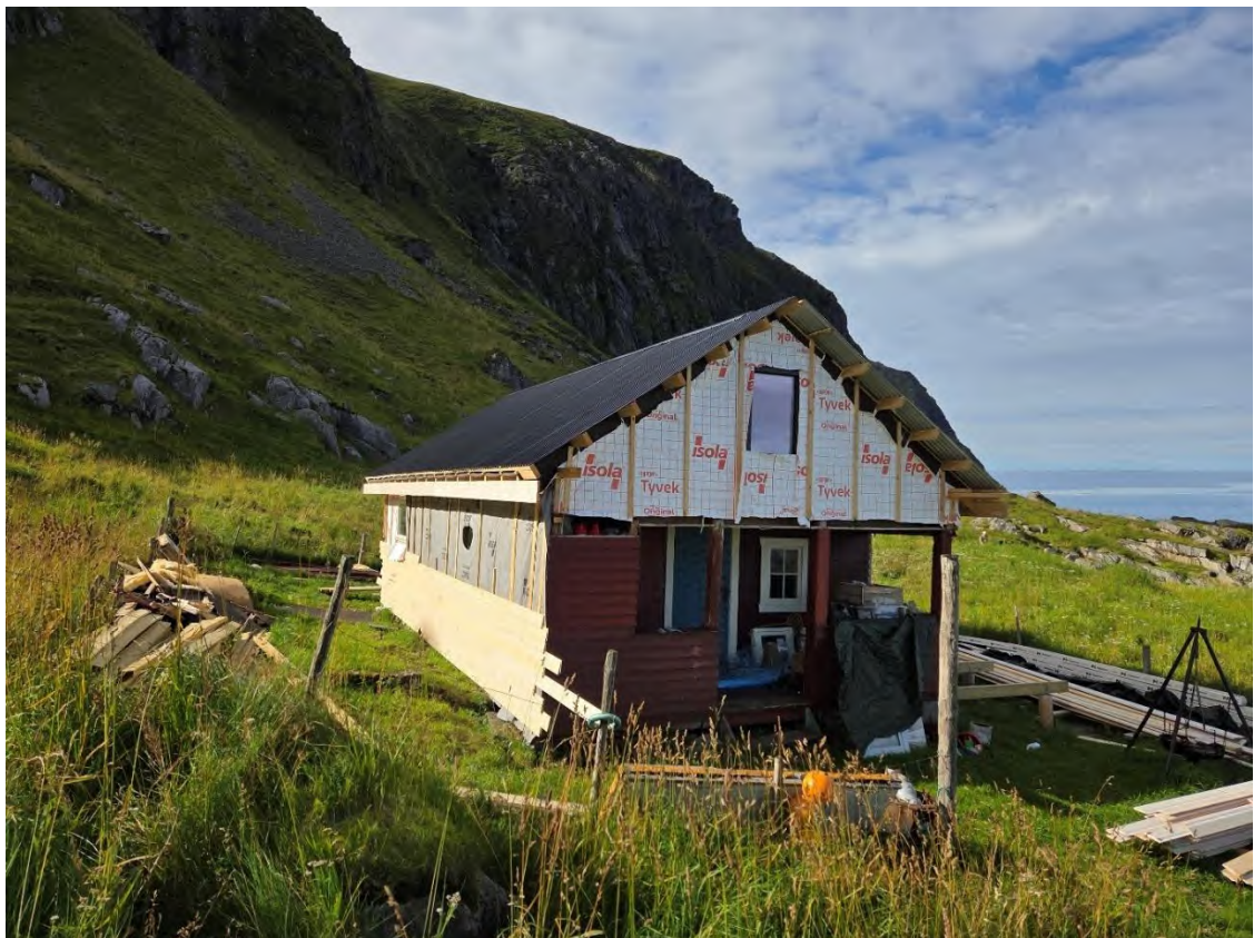
Bilde 6 Gavlvegg mot NØ og langvegg mot SØ
