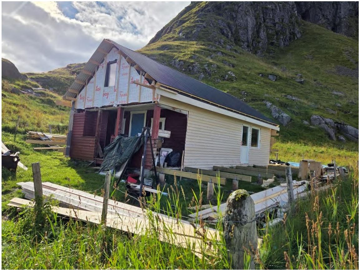
Bilde 5 Langvegg mot NV og gavlvegg mot NØ
