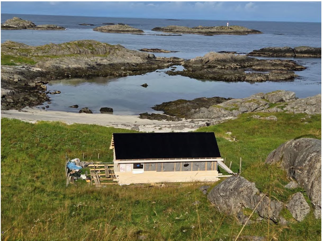
Bilde 2 Langvegg mot SØ
