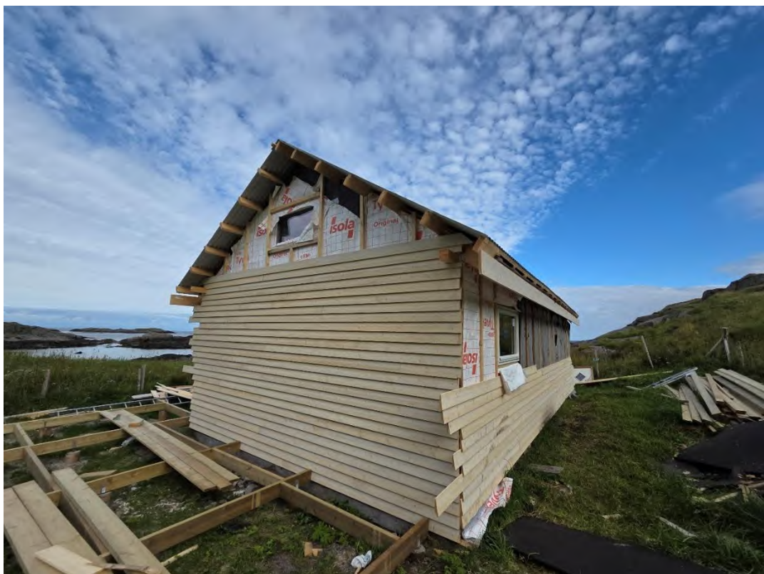
Bilde 10 Gavlvegg mot SV og påbegynt platting, samt langvegg mot SØ,
