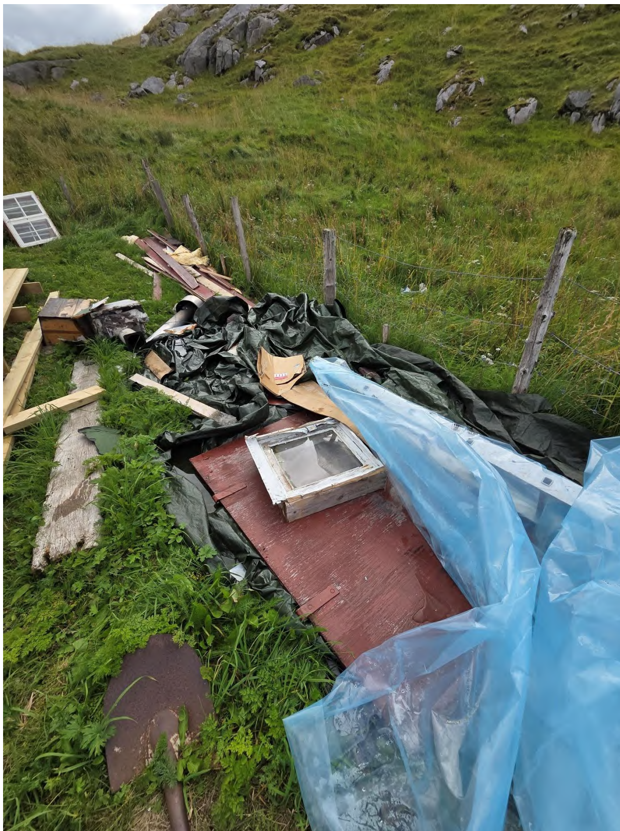
Bilde 32 Detalj av bygningsmaterieell lagret utenfor på sørsiden
