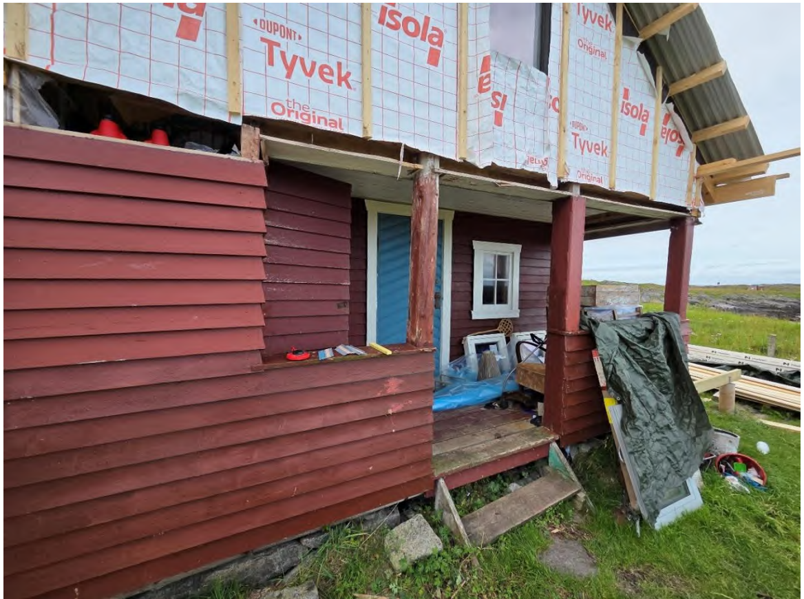
Bilde 15 Detalj av inngangsparti på gavlvegg mot NØ
