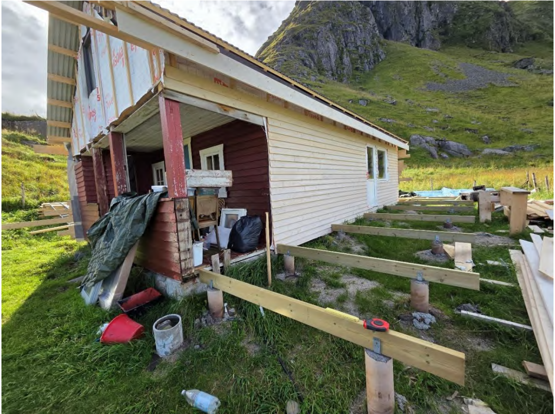
Bilde 7 Langvegg mot NV og påbegynt platting
