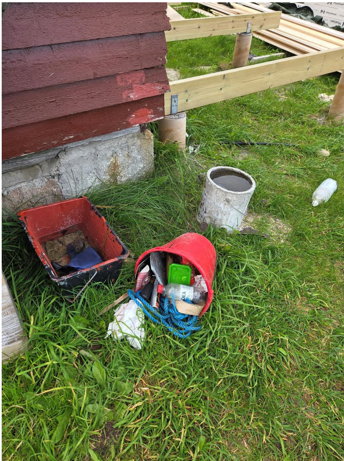
Bilde 39 Detalj som viser nedstøpte stolpesko og illustrerer høyden på nordsiden av påbegynt platting
