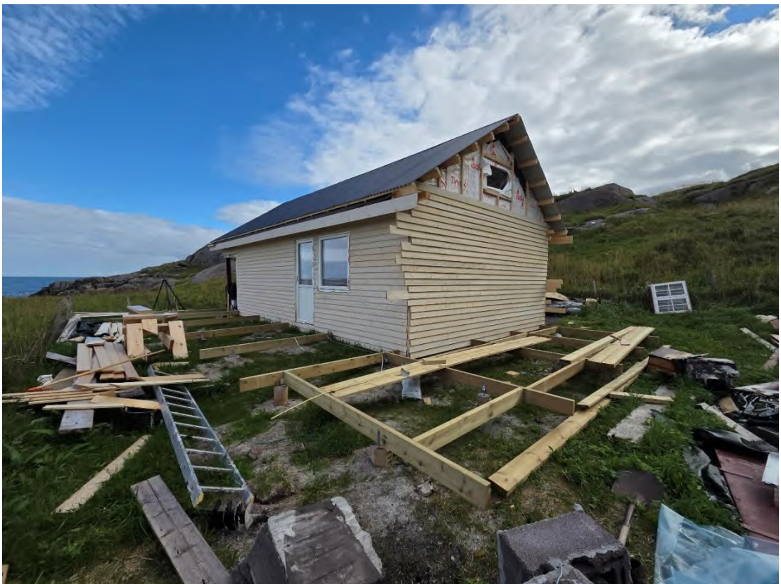
Bilde 8 Langvegg mot NV og gavlvegg mot SV, samt påbegynt platting
