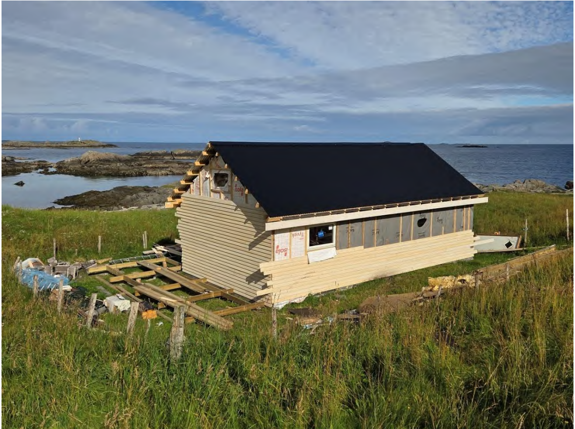
Bilde 3 Langvegg mot SØ og gavlvegg mot SV
