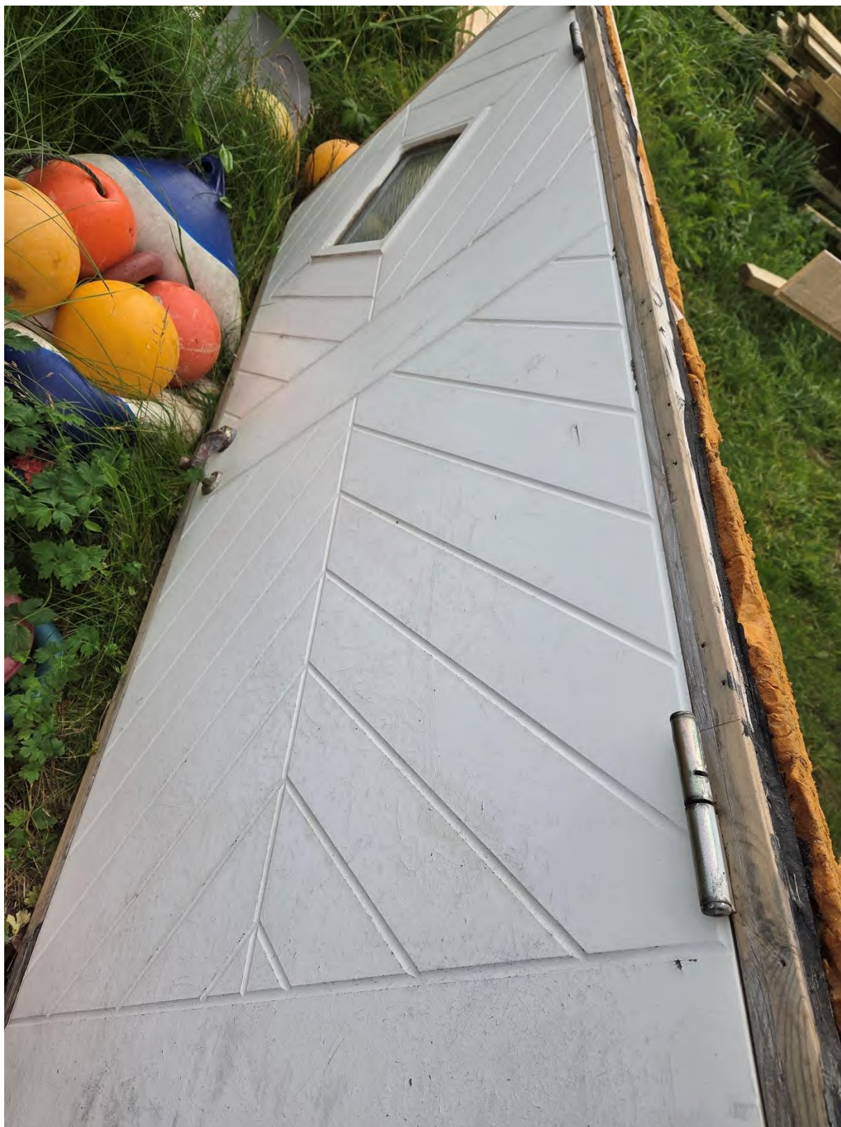
Bilde 38 Detalj av gml ytterdør lagret utenfor på nordsiden
