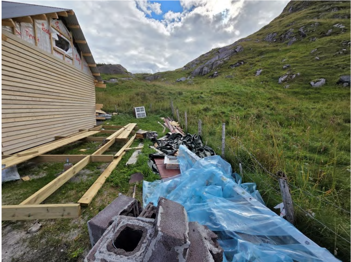
Bilde 9 Gavlvegg mot SV og påbegynt platting, deler av gml pipe i forgrunn
