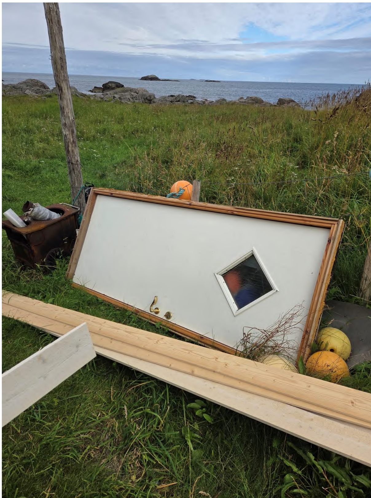
Bilde 37 Detalj av gml ytterdør lagret utenfor på nordsiden
