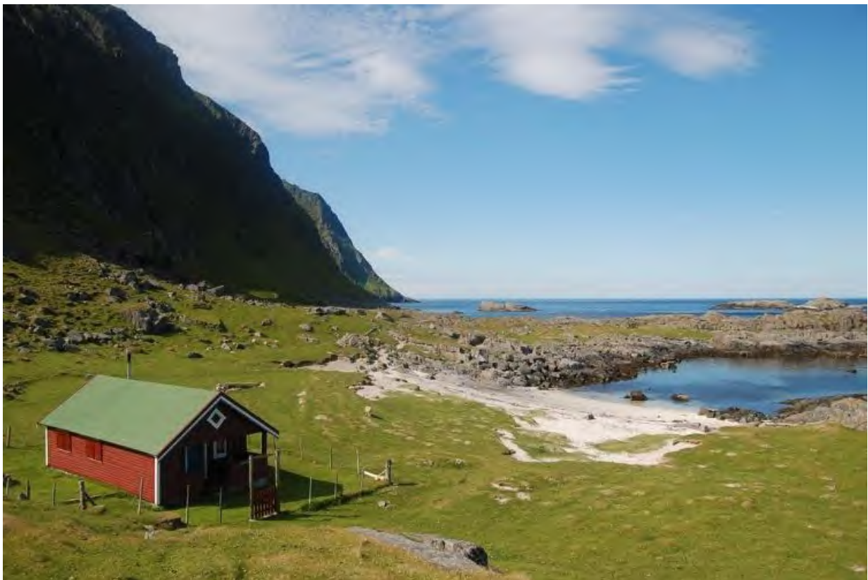
Bilde 41 Langvegg mot SØ og gavlvegg mot NØ, tatt juli 2009. Hentet fra Flickr den 9.9.2025; https://www.flickr.com/photos/20696814@N02/3769728934
