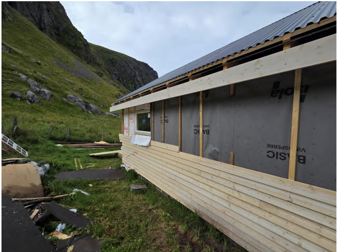
Bilde 11 Detalj av langvegg mot SØ
