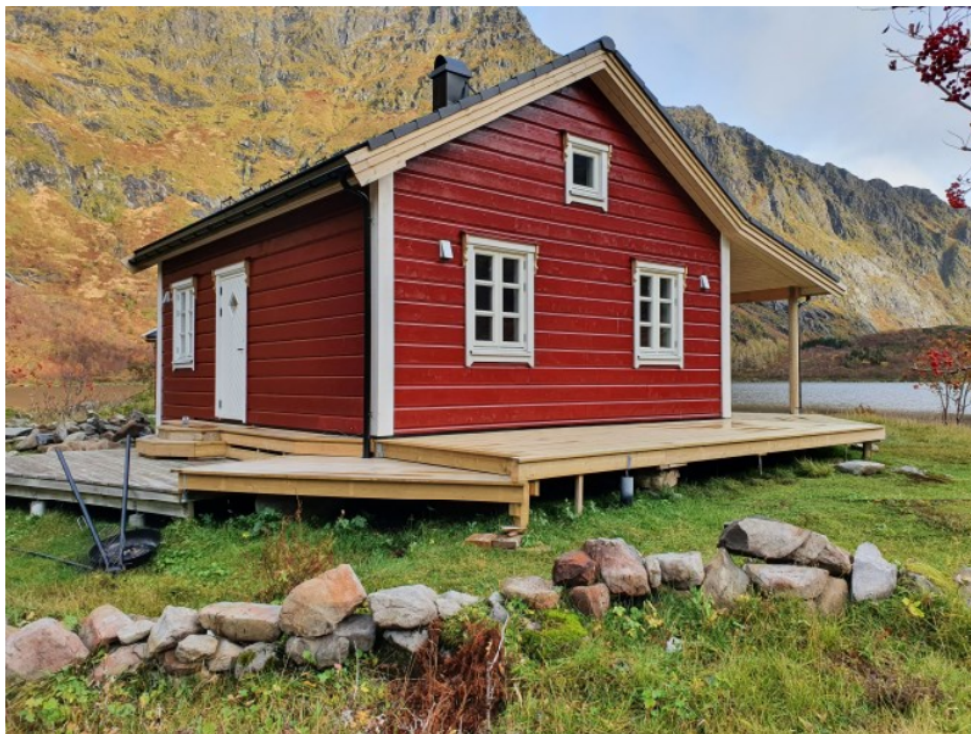
Figur 3. Sørlig og østlig fasade på den nye hytta. Platting i østlig retning har tydelig en annen farge enn resterende plattinger. Det er bygd på ny platting som binder de tre sidene sammen.
