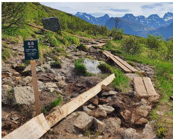
Figur 3 Forsøk på å få folk til å følge nylagt klopp ved hjelp av lavt ledegjerde og skilting.
