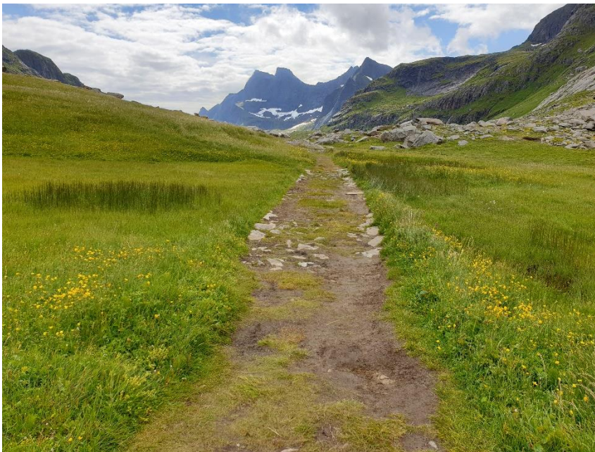
Figur 9. Einangen: Steinlagt vei over en liten myrflate som vitner om den lokale byggeskikken i Lofoten.
