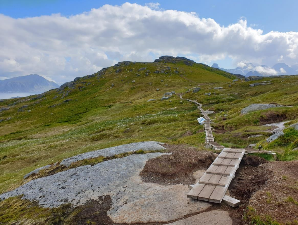
Figur 15. Sensitiv enhet 9 - myr. Stien er klopplagt hele veien i overkant av myrområdet. Dette sørger for god kanalisering av ferdsel.
