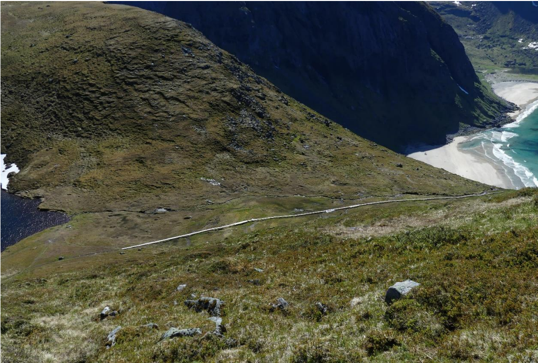
Figur 7. Eksempel på klopplegging som har redusert slitasten på et mindre myrområde (sensitiv enhet 80, myr eller annet fuktig område) på vei ned til Kvalvika.
