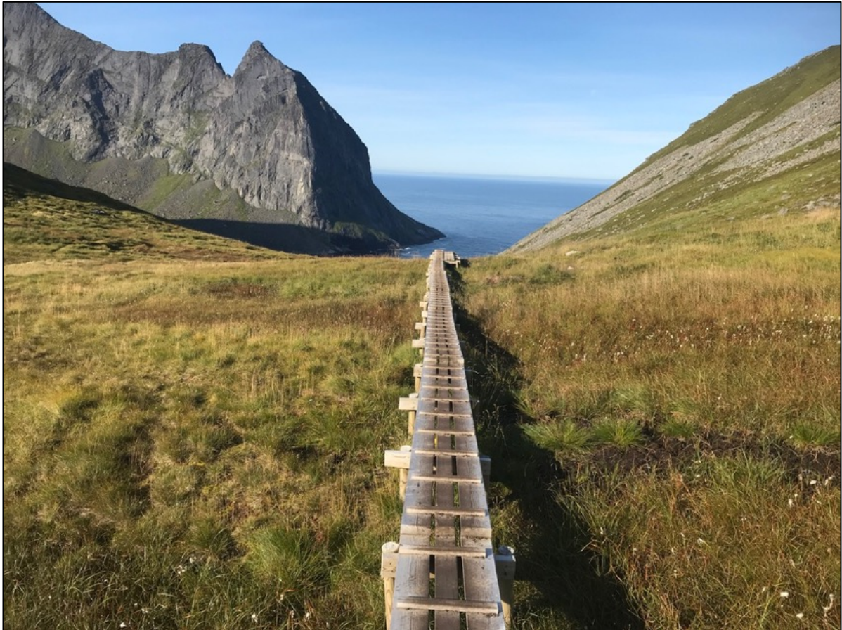
Figur 16 Kloppingen her gir minimal belastning på naturmangfoldet. Her er det møteplasser og trekloppene går i luften slik at vegetasjonen og fuktighetsforholdene under er tilnærmet naturlig. Foto: Mathilde Norby Lorentzen
