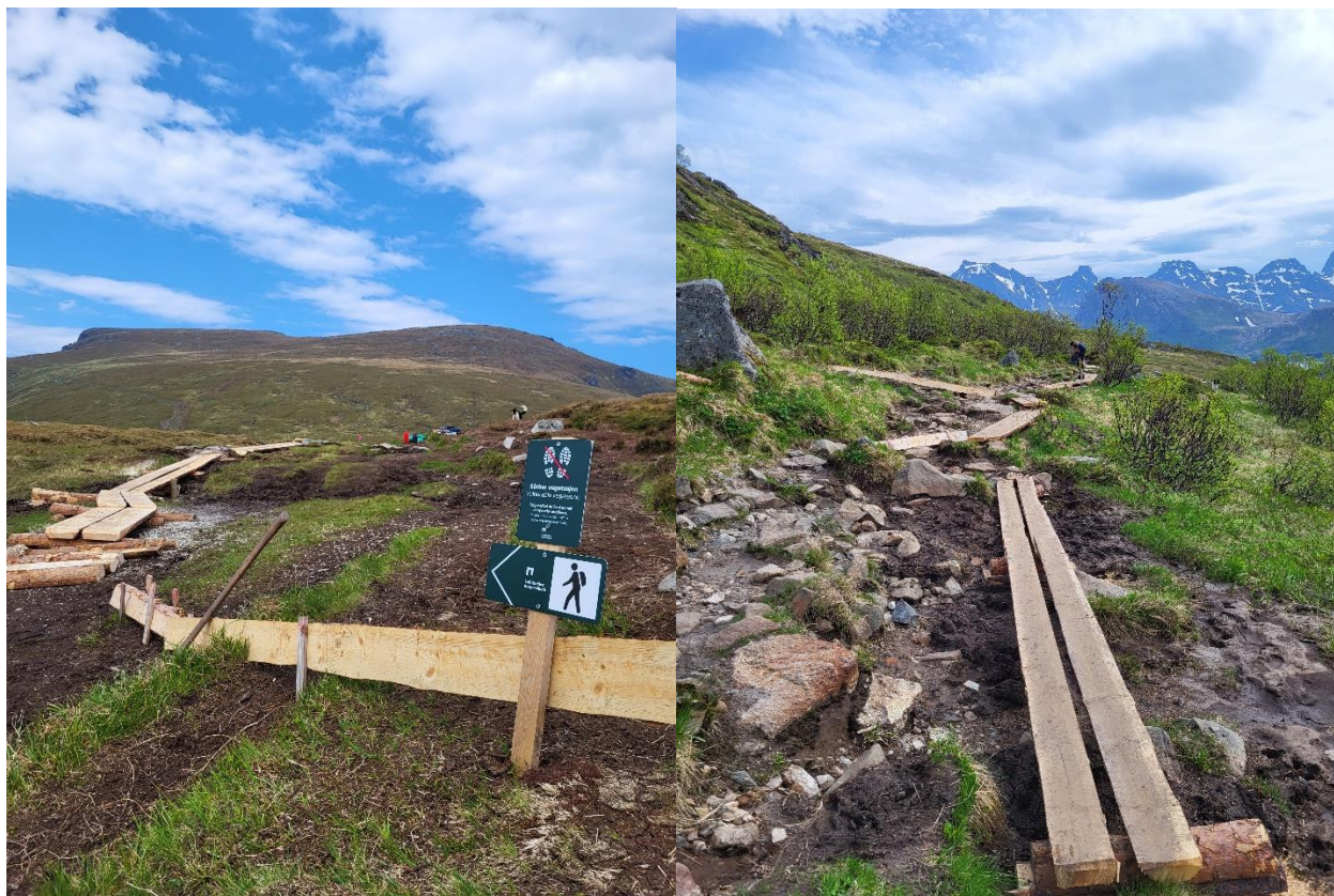
Figur 6. Bilder fra kloppling og kanalisering gjort i 2022. Det ble klopplagt til sammen 136 meter.
