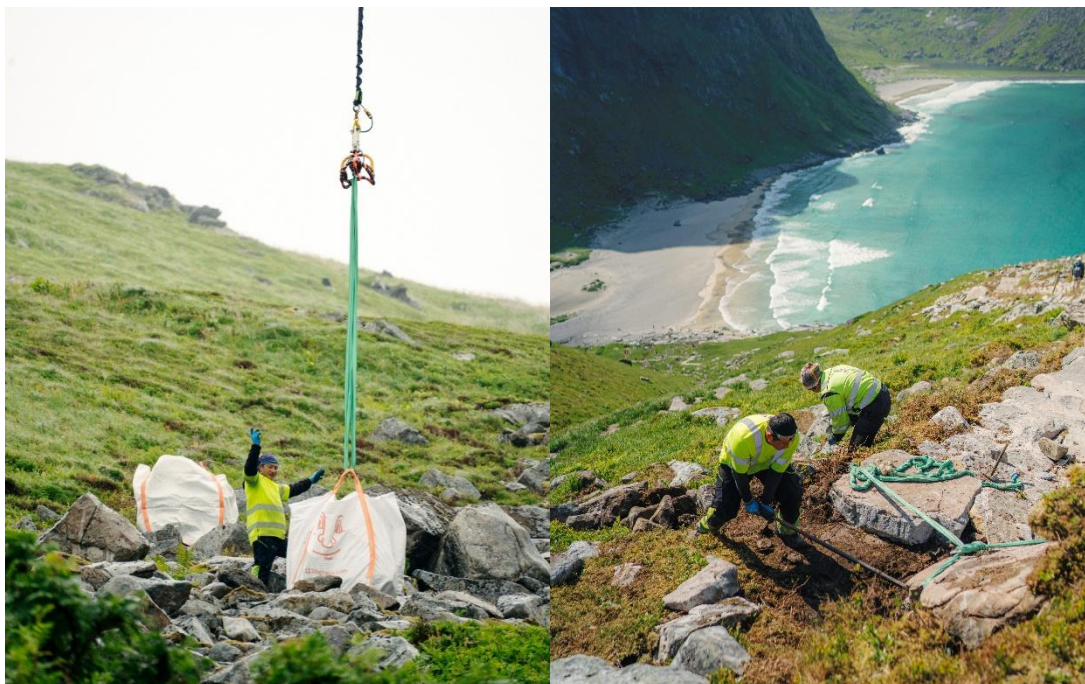
Figur 5. Fra stibyggingen i Kvalvika. Stein som skal brukes til stibygging, hentes fra omkringliggende fjellsider. Steinen pakkes manuelt og transporteres med helikopter til anleggsområdet og rett på stien. Foto: Anna Galina Henriksson.
