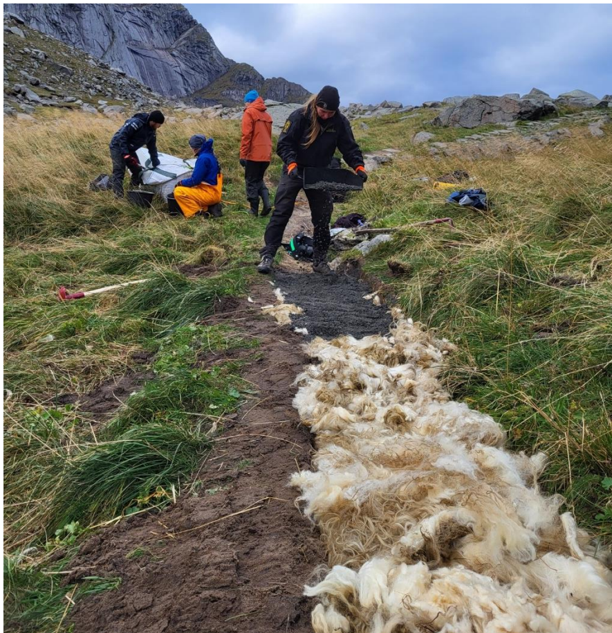
Figur 4. Brit i SNO fyller på med grus ullfeller som er lagt ut i stien.
