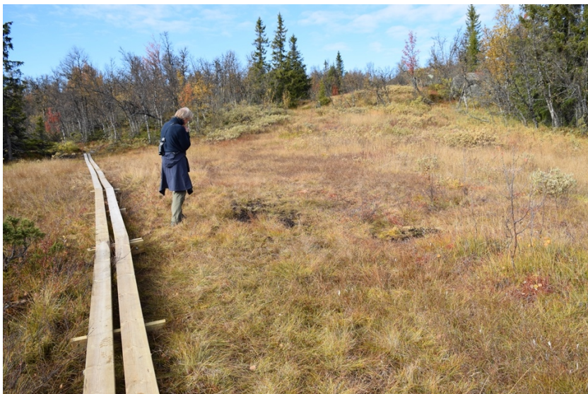
Klopplegging opp mot Røssjøkollene for å reparere myra. Foto: Andrea Vestvik.
