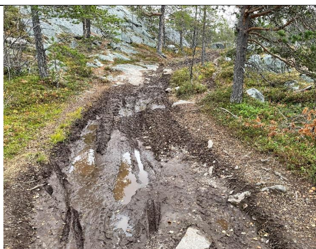
Bildet viser før-situasjon på del av strekningen
