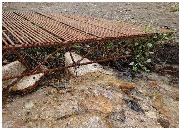
Over: Eksempel på jern-klopp som er i bruk i finske nasjonalparker.
