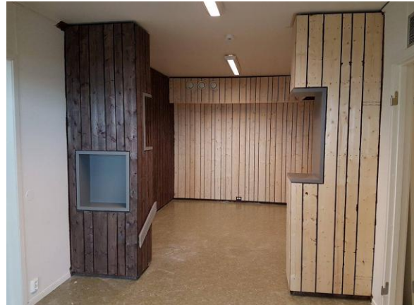
Rom ved avsluttet arbeid
