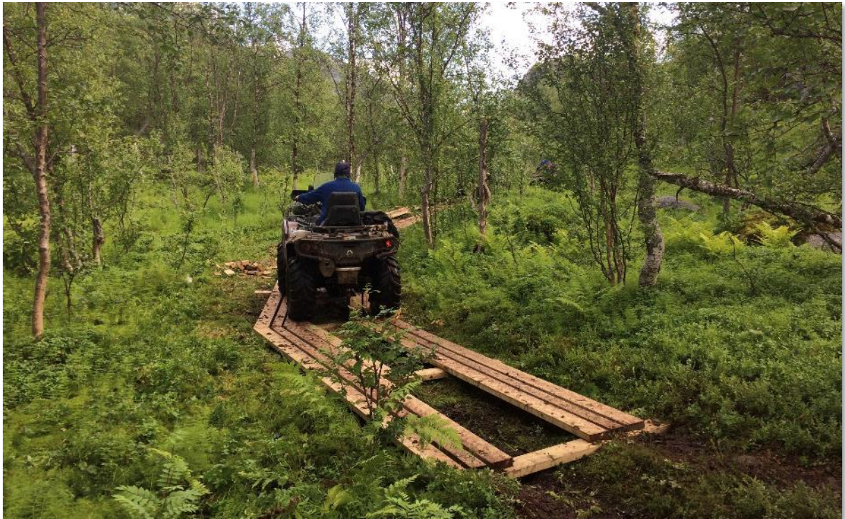
Bilde 5. Forsøk med forsterkning etter kjøresportrasé i Kvænangsbotn. Foto: Rune Benonisen.
