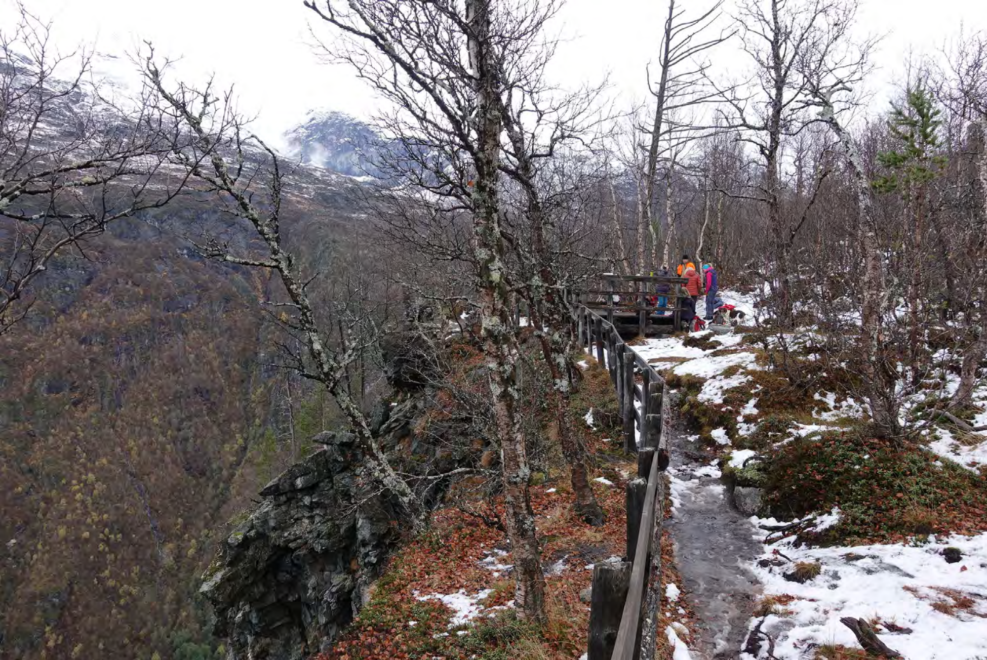
EKSISTERENDE SITUASJON: UTRYGG PLASSERING AV STIGEN LANGS KANTEN AV GJELET
