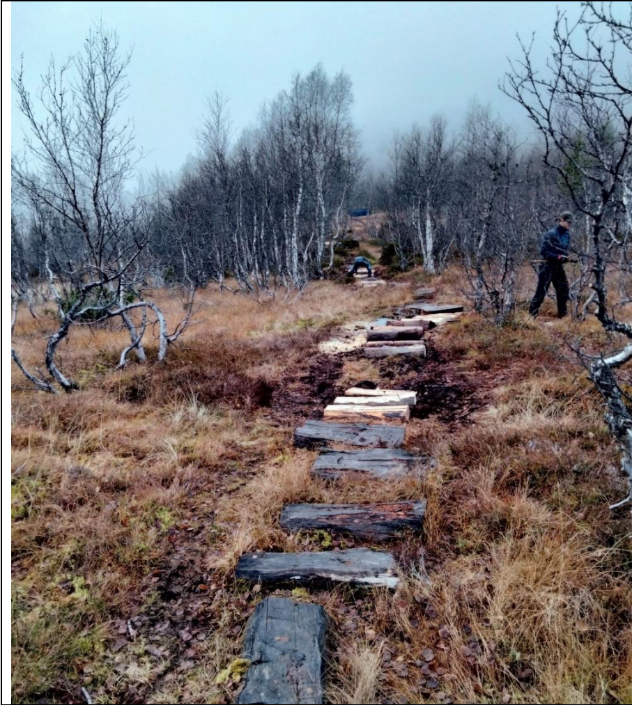
Gjenbruk av gamle kavler og materialar frå det gamle utsiktspunktet. Foto: Samuel A. Båtsvik, Utladalen Naturhus
