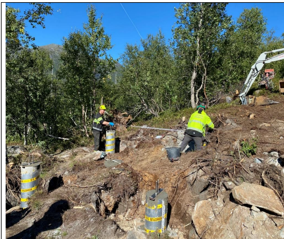
Grundlig arbeid med fundamenta for det nye utsiktspunktet. Fundamenta er trekt inn på trygg grunn. Foto: Eldrid Nedrelo
