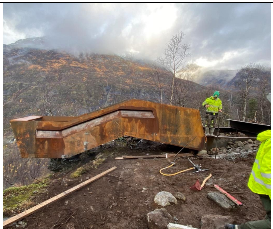
Før arrondering. Fylling med stein sikrar god drenering rundt konstruksjonen. Foto: Eldrid Nedrelo
