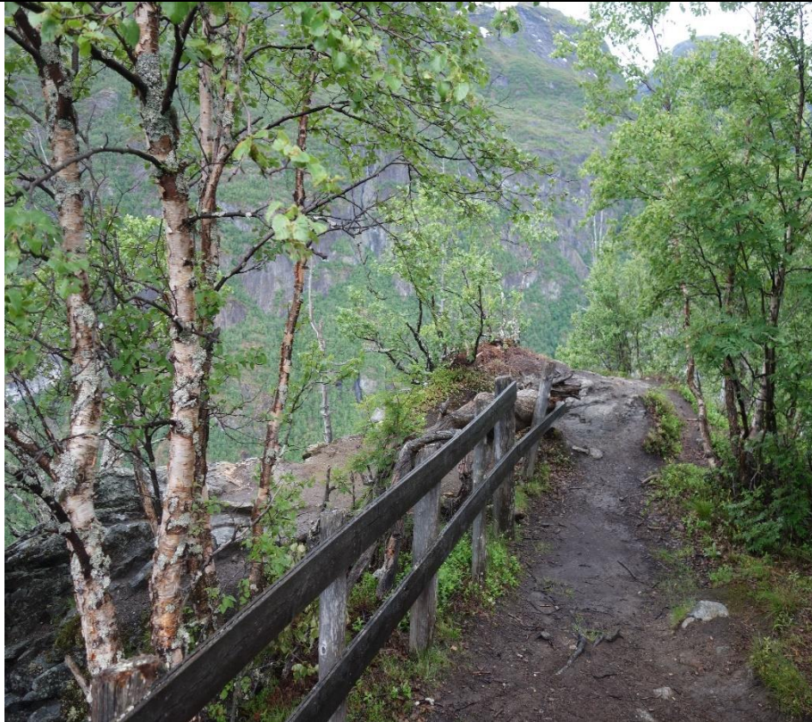
Slitasje ved det gamle utsiktspunktet. Foto: Eldrid Nedrelo
