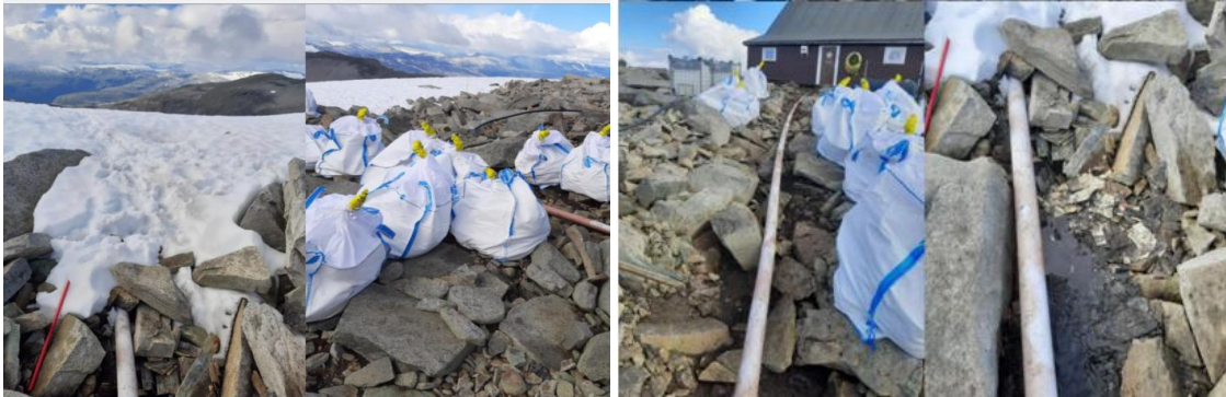
Bilete frå saneringsarbeidet – Foto DNT Oslo og Omegn
