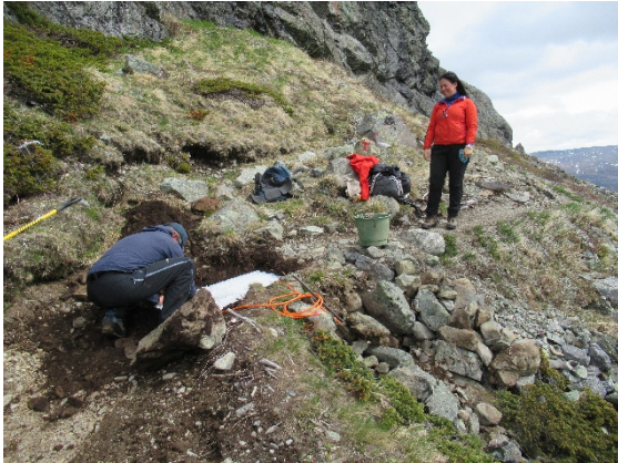
Montering ved Vesleløyfti
