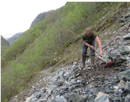
Stien til Vettisfossen blir gravd fram
