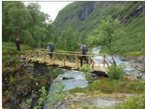
Ny stokkbru over Utna ved Vormeli
