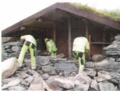
Restaurering av endevegg på vesle steinsetet på Skogadalsbøen
