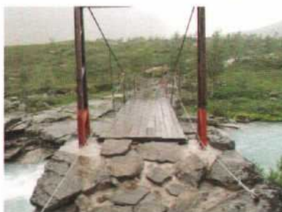
"Storebrui" ferdig reparert
