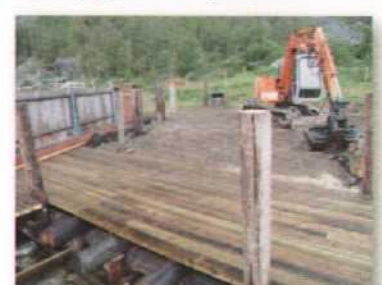
Bygging av ny brygge
