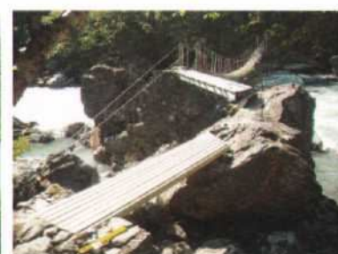
"Brendeteigbrui" ferdig reparert
