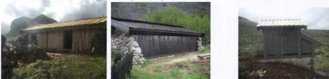
Restaurering av det gamle fjøset frå 1875 ved Gjendebeu vart fullført i 2010, og offisielt opna 3. juli! Ny do vart bygd ved P-plass i Veodalen
