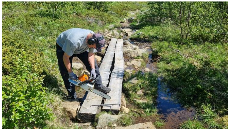
Kavlelegging ved Gjende, foto: Vidar Rugsveen
