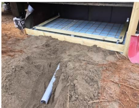
Figur 2 Bilde av sandlag ved Huldreheim
