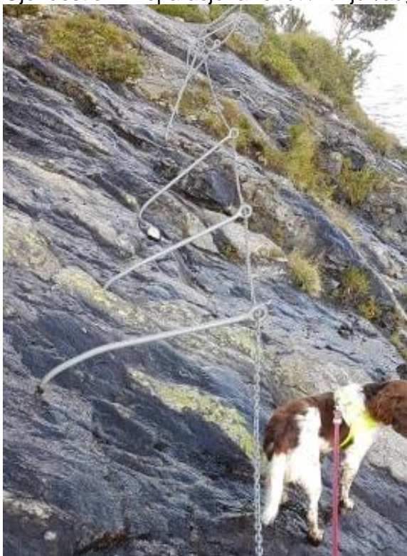
2019: Øydelagt rekkverk
