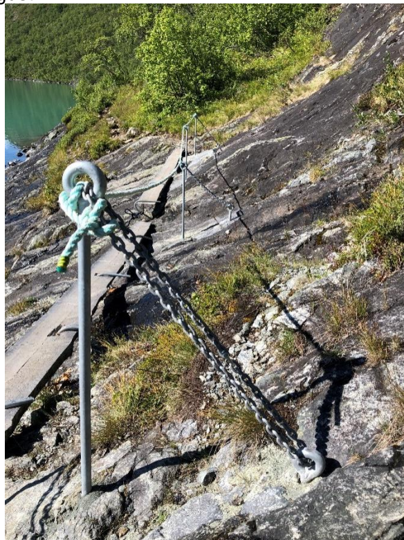
2020: Oppretting og bolta gangbaner over svæet
